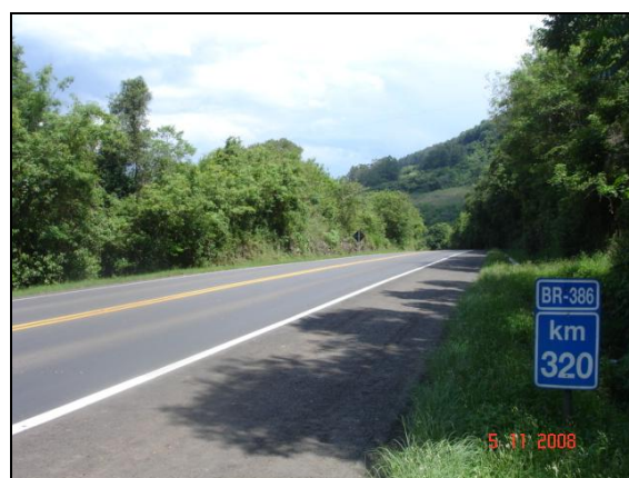
Figura 84 – Trecho 06, BR 386, Km 320
