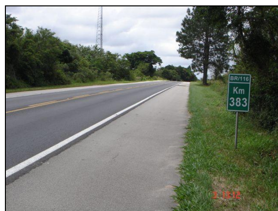
Figura 64 – Trecho 02, BR 116, Km 385
