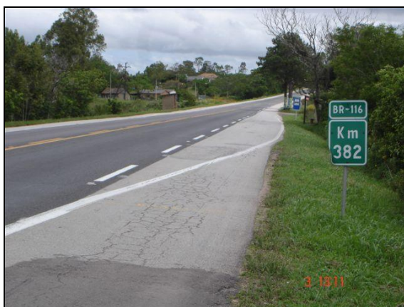
Figura 61 – Trecho 02, BR 116, Km 382
