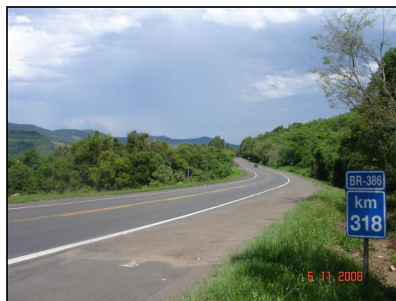
Figura 82 – Trecho 06, BR 386, Km 318
