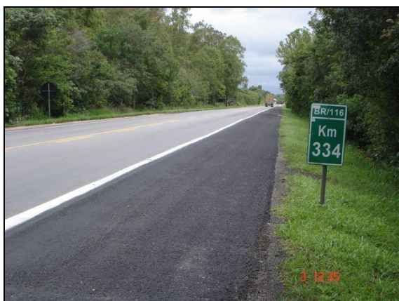
Figura 58 – Trecho 01, BR 116, Km 334
