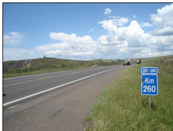
Figura 77 – Trecho 05, BR 386, Km 260
