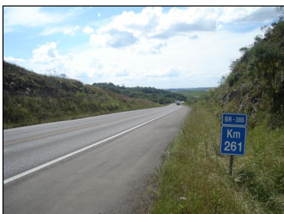
Figura 78 – Trecho 05, BR 386, Km 261
