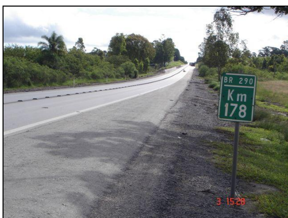
Figura 73 – Trecho 04, BR 290, Km 178
