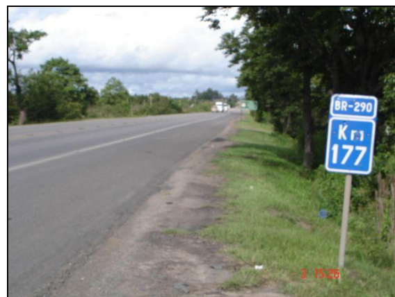
Figura 72 – Trecho 04, BR 290, Km 177
