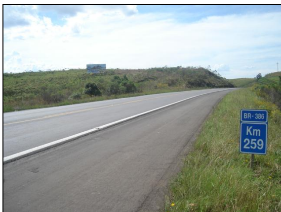
Figura 76 – Trecho 05, BR 386, Km 259
