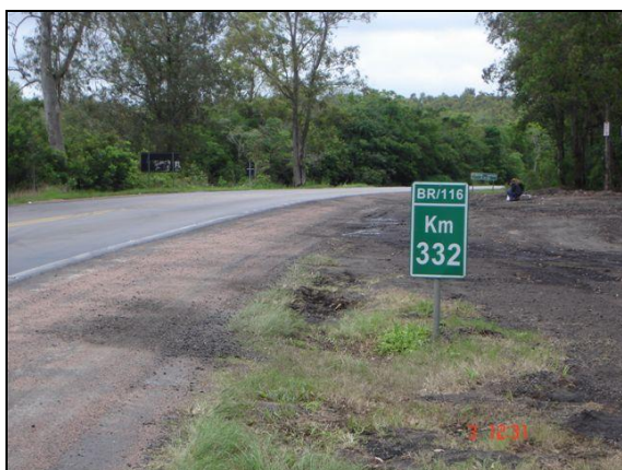
Figura 56 – Trecho 01, BR 116, Km 332
