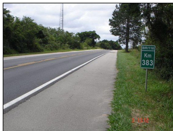
Figura 62 – Trecho 02, BR 116, Km 383
