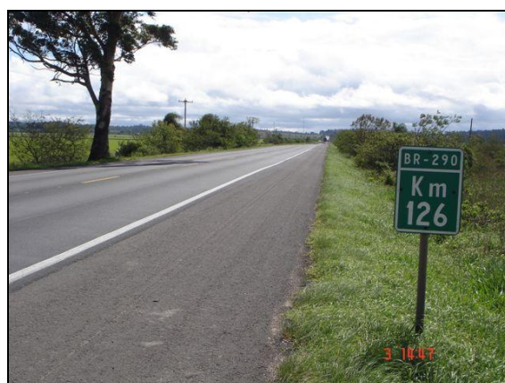
Figura 69 – Trecho 03, BR 290, Km 126
