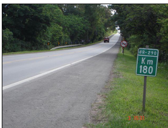
Figura 75 – Trecho 04, BR 290, Km 180
