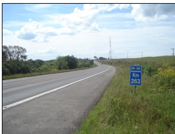
Figura 80 – Trecho 05, BR 386, Km 263
