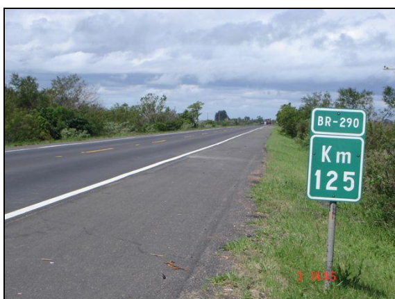
Figura 68 – Trecho 03, BR 290, Km 125
