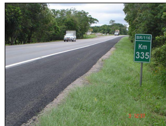
Figura 59 – Trecho 01, BR 116, Km 335
