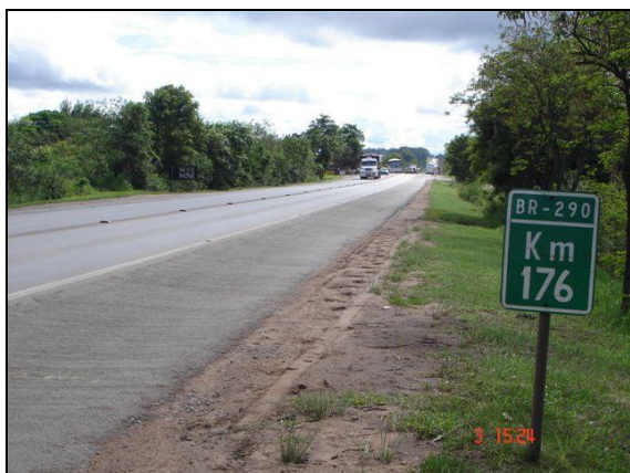
Figura 71 – Trecho 04, BR 290, Km 176
