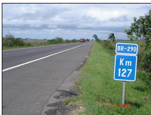
Figura 70 – Trecho 03, BR 290, Km 127
