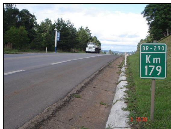
Figura 74 – Trecho 04, BR 290, Km 179
