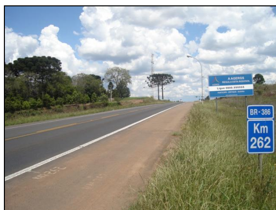
Figura 79 – Trecho 05, BR 386, Km 262
