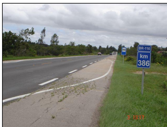
Figura 65 – Trecho 02, BR 116, Km 386
