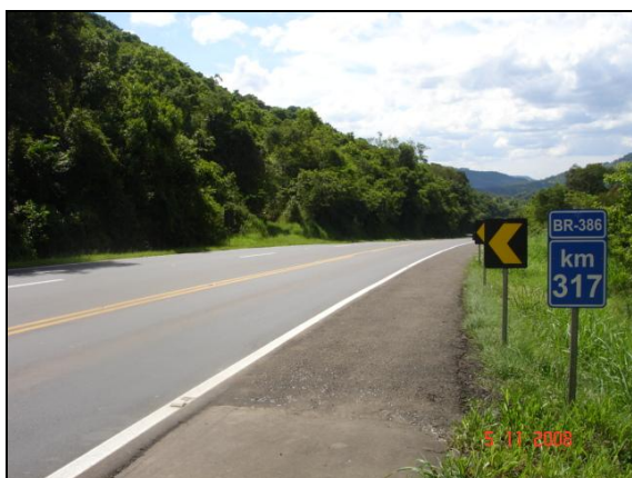
Figura 81 – Trecho 06, BR 386, Km 317
