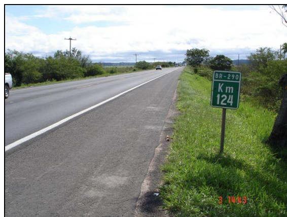
Figura 67 – Trecho 03, BR 290, Km 124
