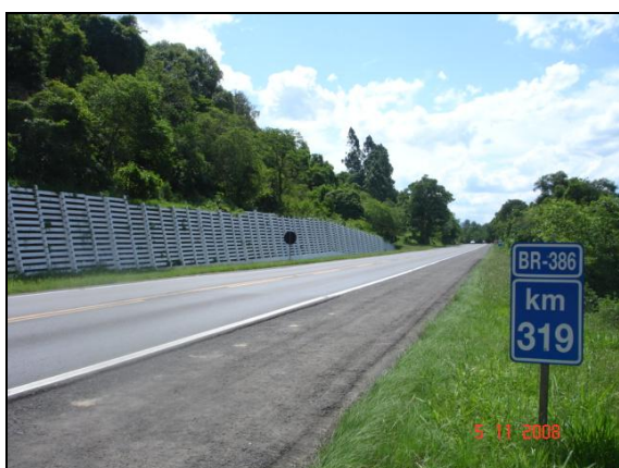
Figura 83 – Trecho 06, BR 386, Km 319
