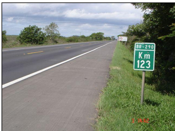
Figura 66 – Trecho 03, BR 290, Km 123
