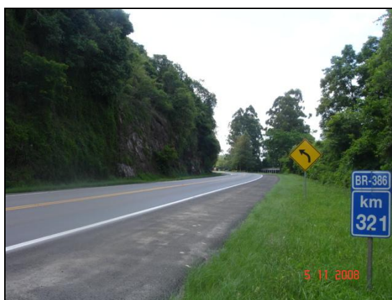
Figura 85 – Trecho 06, BR 386, Km 321
