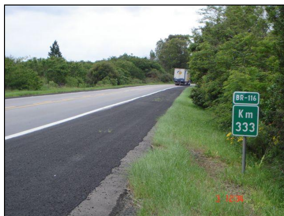
Figura 57 – Trecho 01, BR 116, Km 333
