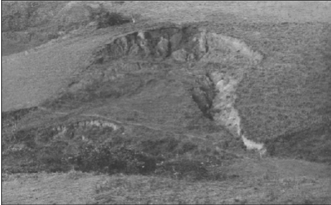
Figura 6 – Exemplo de concavidade aberta, gerado por movimento de massa, topograficamente ajustada com o vale fluvial adjacente. Adaptado de Ana Luiza Coelho Netto, 2003.
