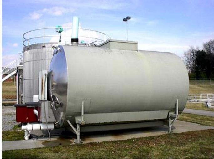
FIGURA 10 – EXEMPLO DE BIOFILTRO FECHADO
