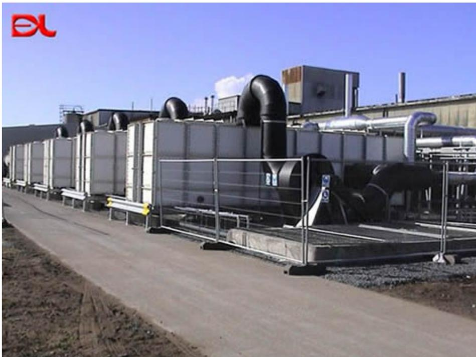
FIGURA 9 - EXEMPLO DE BIOFILTRO FECHADO
