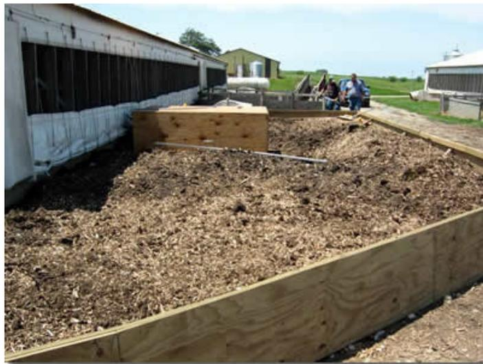
FIGURA 5 - EXEMPLO DE UM BIOFILTRO ABERTO
