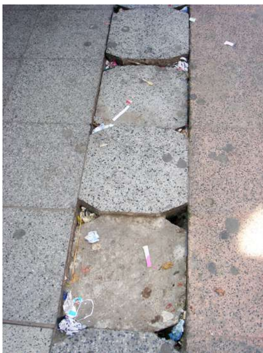
Figura 68 – Grelhas entupidas
