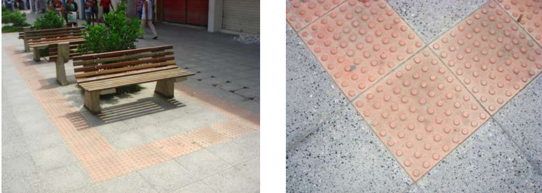
Figura 54 e 55 – Piso tátil demarcando as ilhas de serviço
