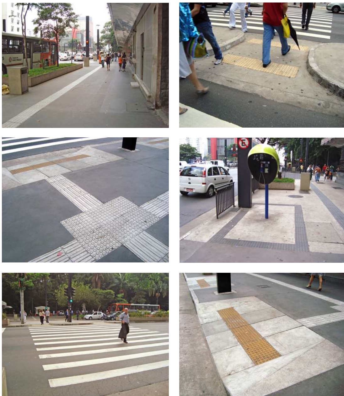
Figura 27, 28, 29, 30, 31 e 32 – Calçada da Avenida Paulista
