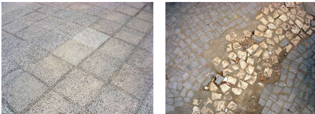
Figura 66 e 67 – Revestimento de piso (atual e antigo)
