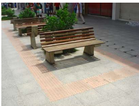
Figura 69 – Ilha de serviço com piso tátil
