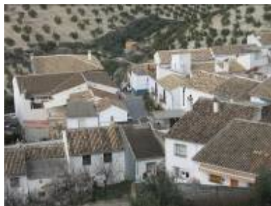
Figura 157: Montefrio, arruamento. Fonte: fotografia da autora, 15/02/2008
