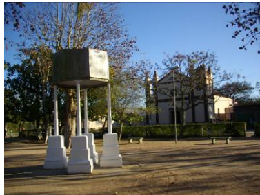
Figura 635: Praça e reservatório Fonte: fotografia da autora, 08/07/2008
