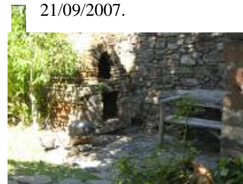
Figura 400: Casa Calle de Los Suspiros, forno. Fonte: fotografia da autora, 21/09/2007.
