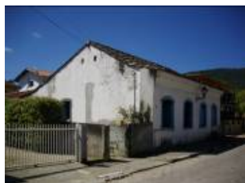
Figura 412: Casa com falsa . Fonte: fotografia da autora, 14/09/2008
