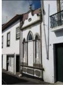
Figura 340: Capela Bairro Santa Luzia, Angra Fonte: fotografiada autora, 03/03/2008.
