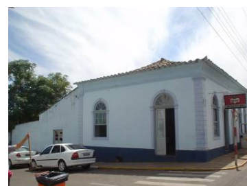
Figura 630: Casa Rua Oswaldo Aranha 1872 Fonte: fotografia da autora, 13/03/2006.
