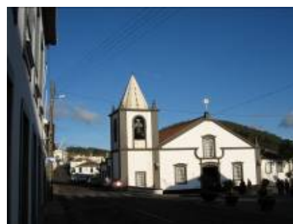
Figura 285: Freguesia de Santa Bárbara. Igreja Fonte: Fotografia da autora, 02/03/2008
