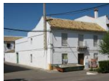
Figura 449: La Luisiana. Casa de dois pavimentos. Fonte: fotografia da autora, 30/02/2008
