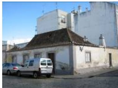
Figura 460: Casa original Fonte: fotografia da autora, 17/02/2007
