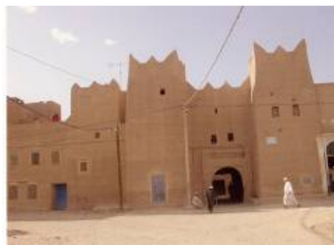
Figura 134: Ighem El Khorbat, Acesso. Fonte: Soriano, 2006, p. 100.
