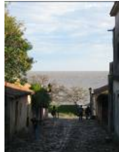
Figura 378: Calle de los Suspiros , calçamento de pedra com drenagem central. Fonte: fotografia da autora, 21/09/ 2007.
