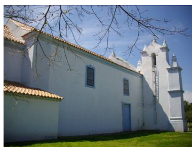
Figura 550: Igreja, vista lateral Fonte: fotografia da autora, 25/09/2008
