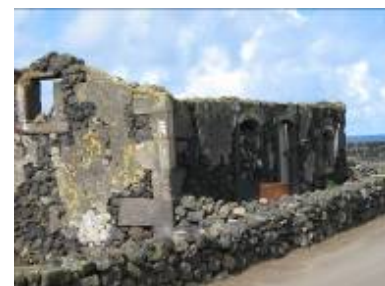
Figura 324: Ruínas de casa rural térrea com falsa, Caldeira, Fonte: fotografia da autora, 04/03/2008
