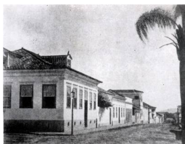
Figura 626: Casa Rua Sete de Setembro esquina Rua Margarida Ribeiro na década de 1920. Fonte: a. Costa e Silva, 1971
