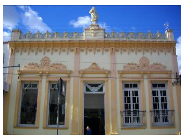
Figura 694: Casa residencial Fonte: fotografia da autora, 01/06/2008
