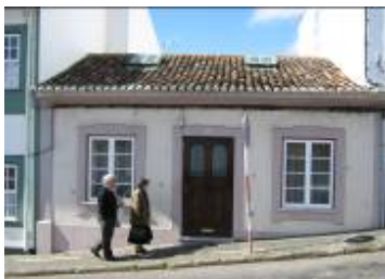
Figura 328: Casa térrea na rua Canos Verdes. Angra do Heroísmo Fonte: fotografia da autora, 04/03/2008
