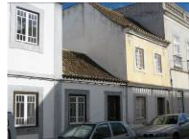
Figura 461: Casas modificadas Fonte: fotografia da autora, 17/02/2007
