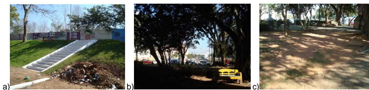
Figura 4.13 – Problemas de falta de manutenção na Praça do Imigrante: a) Lixo acumulado na Praça; b) Pouca luminosidade deixa a Praça escura e úmida; c) Falta grama em muitos canteiros e os usuários cortam caminho por eles. Fonte: autora, 2008.
