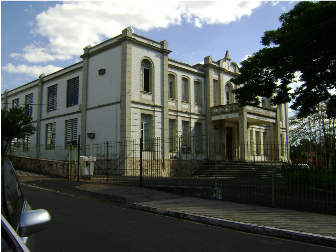
Figura 31: Vista do prédio da Universidade Federal do Triângulo Mineiro (foto-2009).
