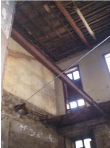
Imagem 415 – Reforço estrutural do prédio, 2005.
