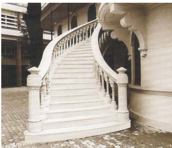
Imagem 94 – Escada externa da Mansão Figner.
