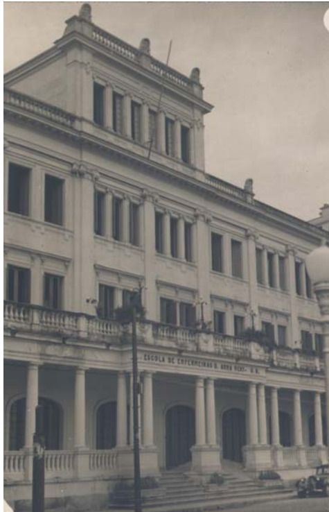
Imagem 255 – Entrada do hotel – escadaria, loggia e colunatas.
