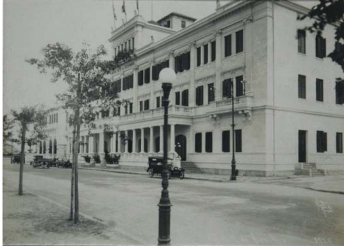
Imagem 220 – Prédio do Hotel finalizado.
