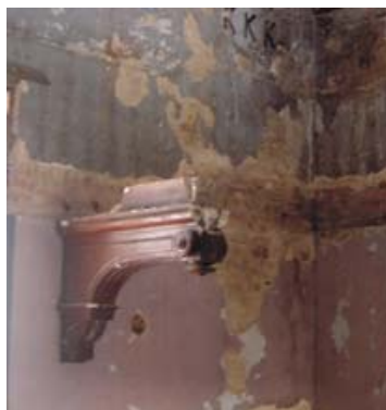
Imagem 294 – Detalhe das mísulas estruturais – durante os trabalhos de restauração.
