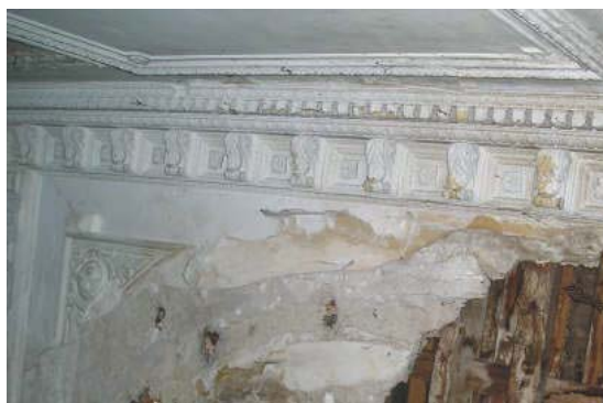
Imagem 396 – Detalhe do forro em estuque – 1 pavimento, 2005.
