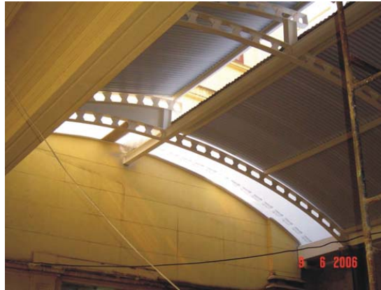
Imagem 321 – Cobertura metálica colocada no pátio de convivência.
