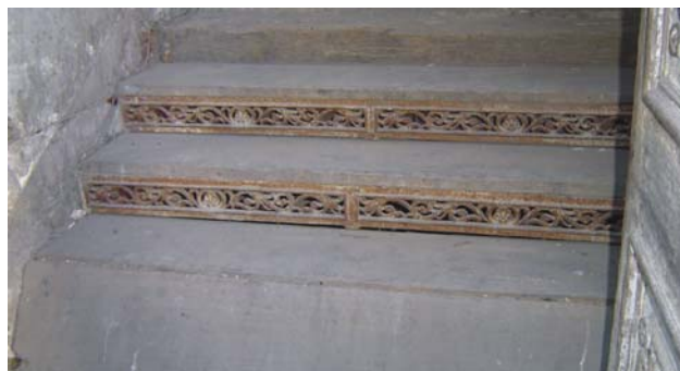
Imagem 406 – Escada de acesso, 2008.
