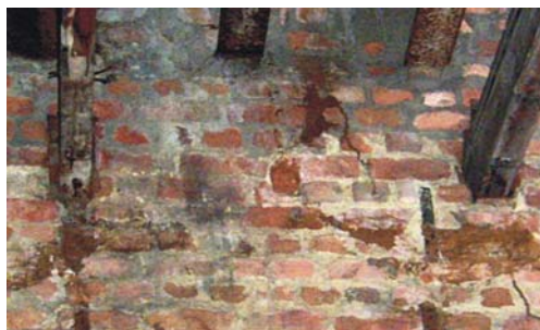
Imagem 46 – Parede situada no 4 pavimento do edifício principal do Hotel Sete de Setembro – alvenaria de tijolos maciços dispostos em duas fiadas paralelas ao comprido e uma atravessada.
