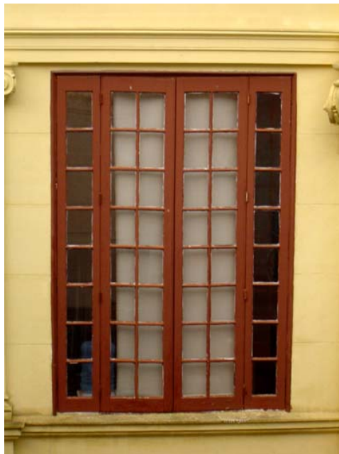
Imagem 281 – Janela do 2º pavimento, prédio Anexo.
