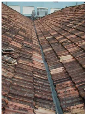
Imagem 326 – Detalhe da calha do telhado do prédio Anexo.
