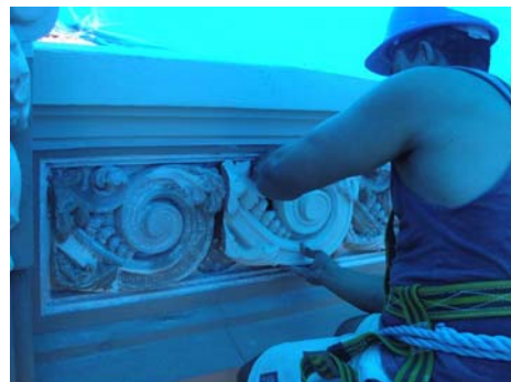
Imagem 191 – Colocação do ornato.
