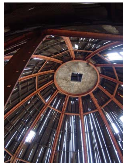
Imagem 414 – Recuperação da cúpula – vista interna, 2005.
