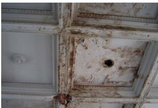
Imagem 397 – Detalhe do forro em estuque – 2 pavimento, 2005.
