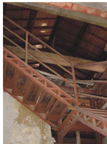
Imagem 418 – Instalação de uma nova escada metálica, 2005.
