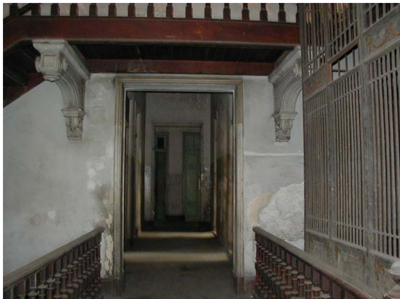
Imagem 295 – Escada funcionando como passarela.
