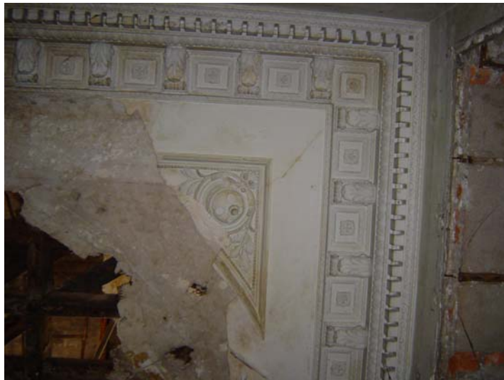
Imagem 430 – Teto em estuque – hall acesso, 2005.
