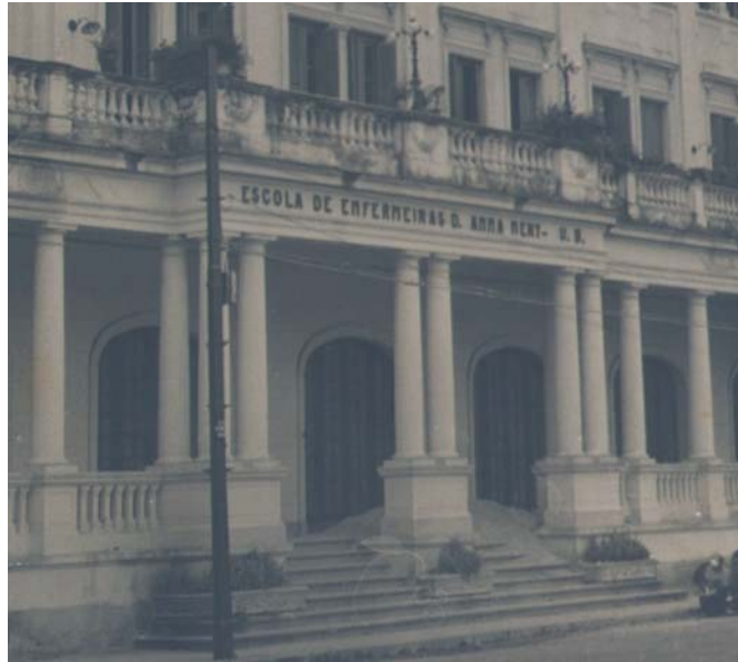
Imagem 290 – Escadaria principal - fachada.
