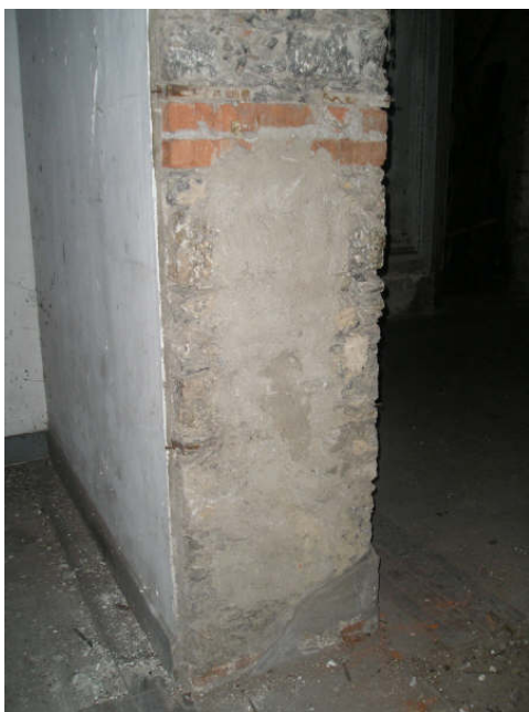
Imagem 385 – Vista da base do sistema construtivo de alvenaria mista com faixas de pedra e faixas tijolos maciços – foto do 1 pavimento, 2008.
