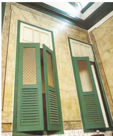
Imagem 47 – Casa de 1910 à rua Moraes e Vale, nº 20 - parede com pintura fingindo mármore e granito.
