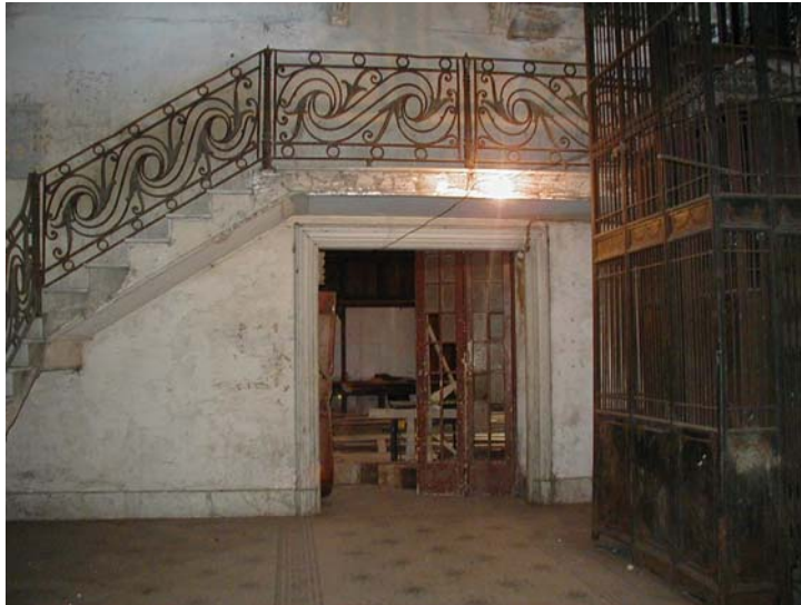
Imagem 292 – Escada do prédio principal – hall principal – 1 pavimento.
