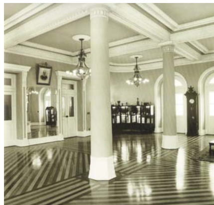
Imagem 70 – Salão nobre do Quartel Central do Corpo de bombeiros – forro topo caixotões de estuque.
