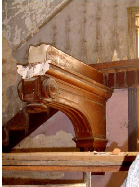
Imagem 341 – Modilhões revestidos de gesso –prédio Principal.
