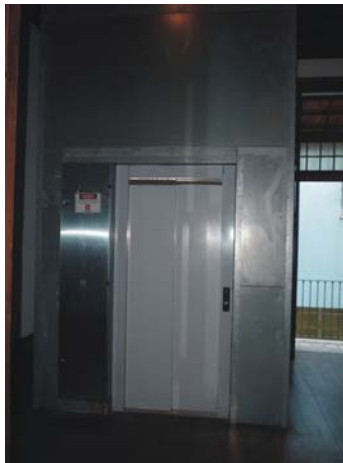
Imagem 331 – Elevador, prédio Anexo.
