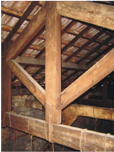
Imagem 151 – Estrutura do telhado – Estruturas internas do telhado: tesouras, terças, caibros, 2005.
