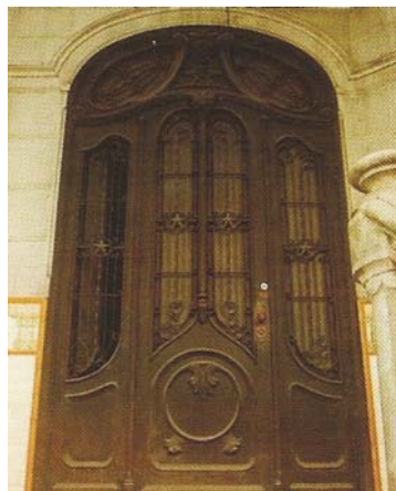
Imagem 79 – Porta principal da Mansão Figner – caixilhos com fechamento em vidro e grades de ferro fundido entaladas.
