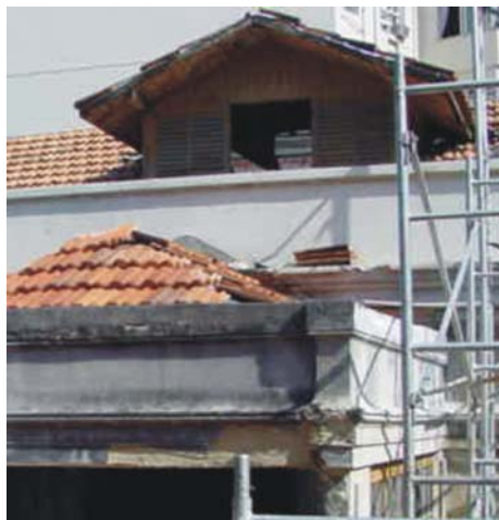
Imagem 93 – Água-furtada do edifício anexo do Hotel Sete de Setembro, 2002.
