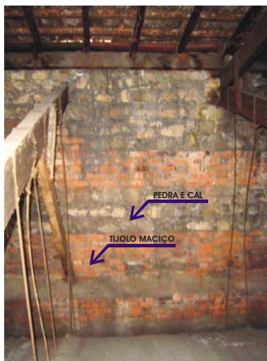
Imagem 138 – Vista do sistema construtivo de alvenaria mista com faixas de pedra e cal e faixas tijolos maciços – foto do telhado da Escola de Música, 2005.
