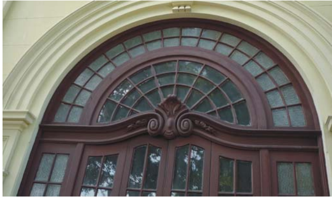
Imagem 280 – Detalhe da caixilharia, 2009.
