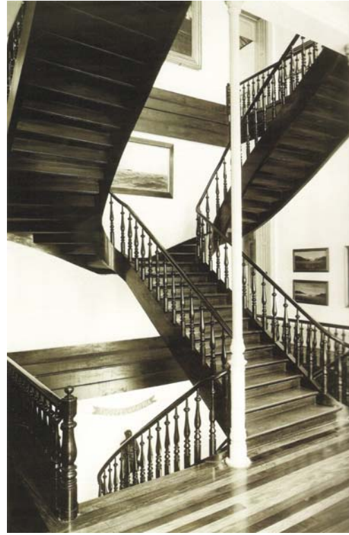
Imagem 97 – Saguão do Museu Naval e Oceanográfico, antigo Clube Naval - escada em madeira com balaústres torneados e degraus em madeira à mostra e entalhados nas pernas.
