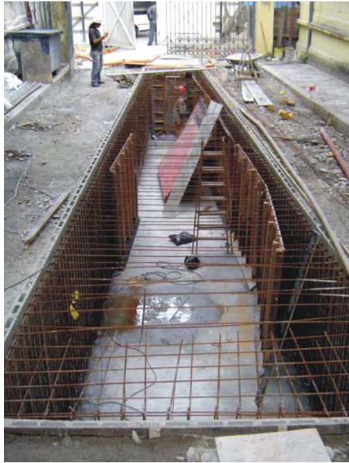
Imagem 319 – Execução da nova cisterna.
