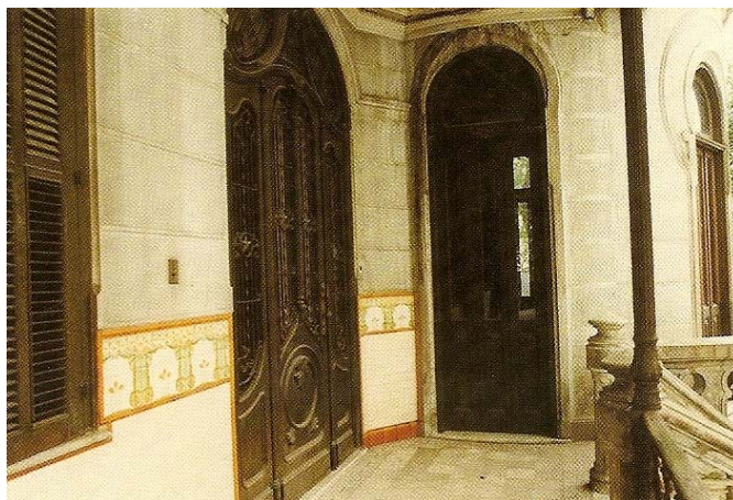
Imagem 51 – Parede revestida com lambris de azulejo com barra decorada em relevo e colorida na parte superior.
