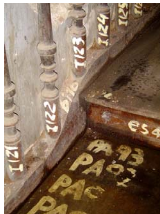
Imagem 336 – Detalhe da marcação da escada hall lateral – prédio Principal.
