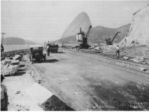
Imagem 208 – Construção da Avenida do Morro da Viúva - fase de calçamento - década de 20.
