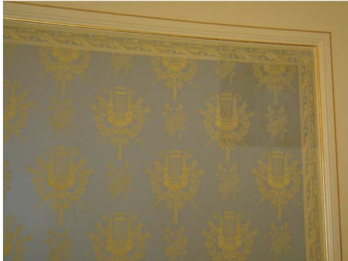
Imagem 201– Painel já pronto, mostrando a diferença entre a pintura original - janela arqueológica – e a restaurado, 2008.
