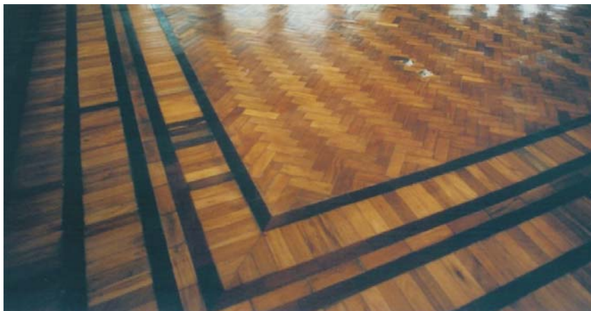
Imagem 266 – Piso do salão principal do 2 pavimento do prédio Anexo.
