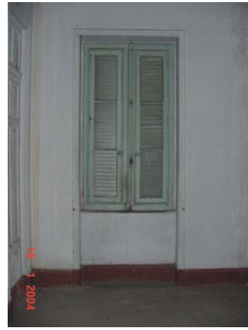
Imagem 285 – Janela face interna.
