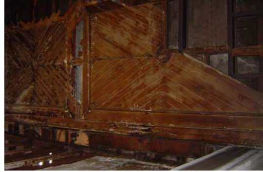
Imagem 399 – Detalhe do forro em madeira da circulação – 2 pavimento, 2005.
