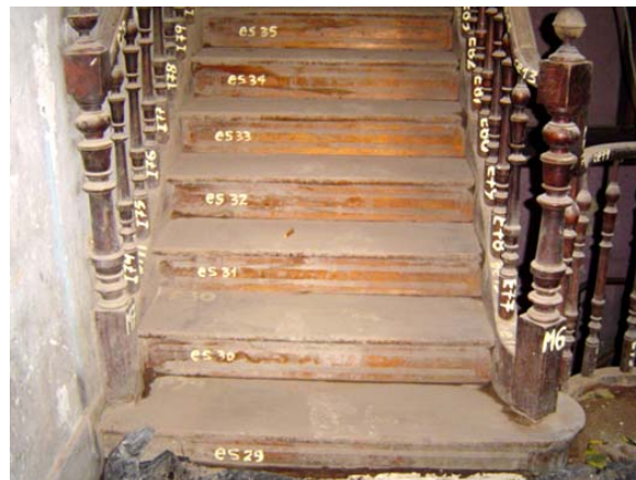
Imagem 335 – Escada hall lateral – prédio Principal.
