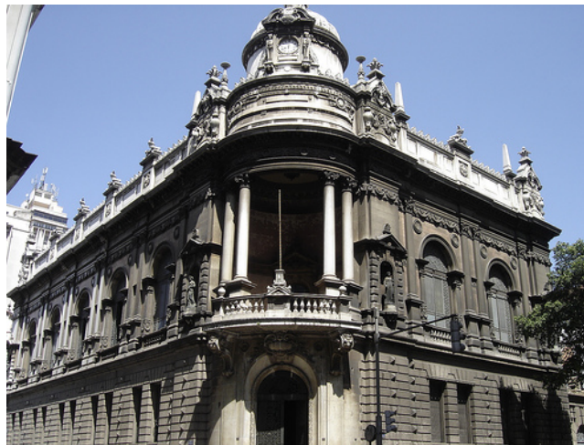
Imagem 27 – antigo Tribunal Regional Eleitoral – Exemplo de fachada de esquina, Rio de Janeiro, década de 1890.
