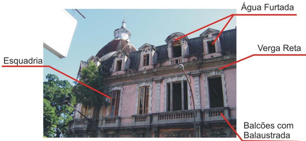
Imagem 383 – Foto do segundo e terceiro pavimento da edificação – elementos ecléticos destacados.
