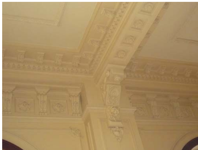
Imagem 273 – Teto em estuque – 1 pavimento, prédio Anexo, 2009.
