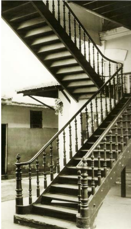
Imagem 96 – Escola municipal Tiradentes - escada em madeira com balaústres torneados, primeiro degrau de pedra e os demais em madeira, à mostra inferiormente e entalhados nas pernas.
