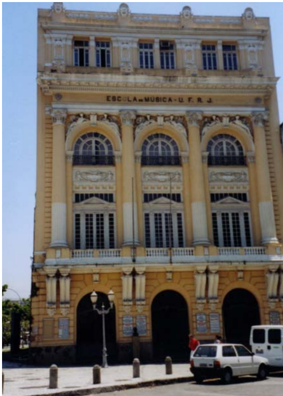
Imagem 186 – Fachada da Escola de Música antes da restauração, 2005.
