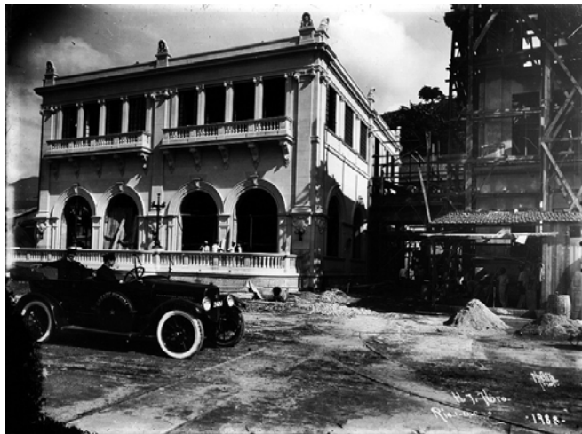
Imagem 219 – Prédio do Restaurante quase acabado ao lado do prédio do Hotel ainda em construção.
