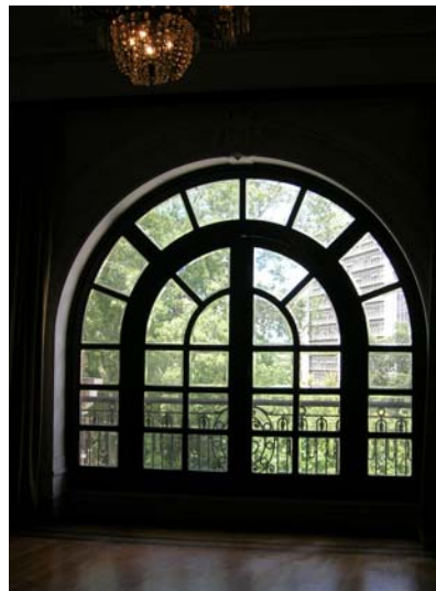
Imagem 149 – Janela em arco pleno de três folhas com vidro bisotado, 2005.
