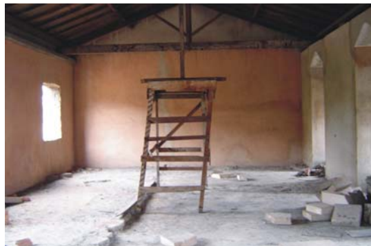
Imagem 412 – Recuperação do madeiramento do telhado, 2005.
