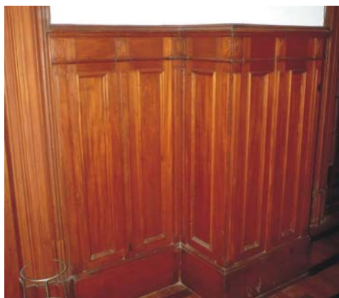
Imagem 52 – Lambri almofadado, composto por peças de madeira encaixadas – localizado no salão principal do segundo pavimento do Edifício anexo do Hotel Sete de Setembro, depois das obras de restauração.
