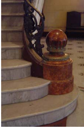
Imagem 154 – Escada em mármore – lado direito – detalhe da base do corrimão, 2007.
