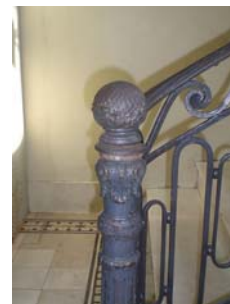
Imagem 158 – Escada posterior em mármore - detalhe da base do corrimão em ferro fundido, 2005.
