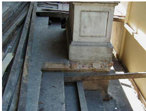
Imagem 291 – Escada principal - detalhe.
