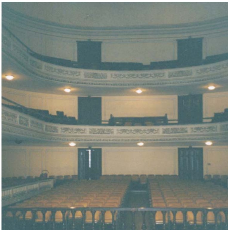
Imagem 202 – Aspecto do Salão Leopoldo Miguez antes da restauração –visto de cima do palco, 2005.
