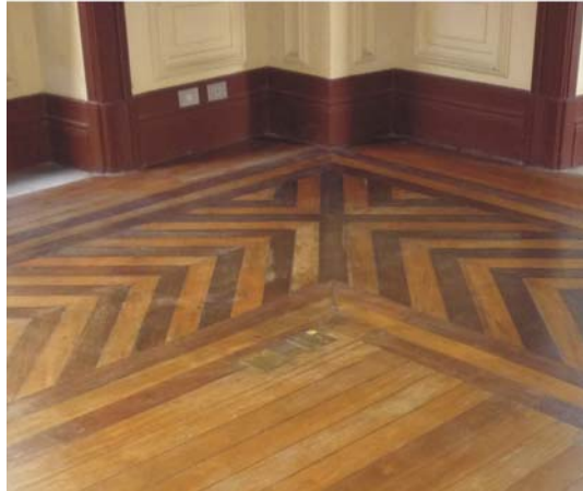
Imagem 265 – Piso do salão principal do 1 pavimento do prédio Anexo, 2009.
