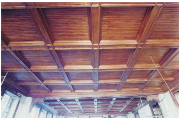
Imagem 69 – Forro tipo caixotões de madeira – salão do segundo pavimento do edifício anexo do Hotel Sete de Setembro.
