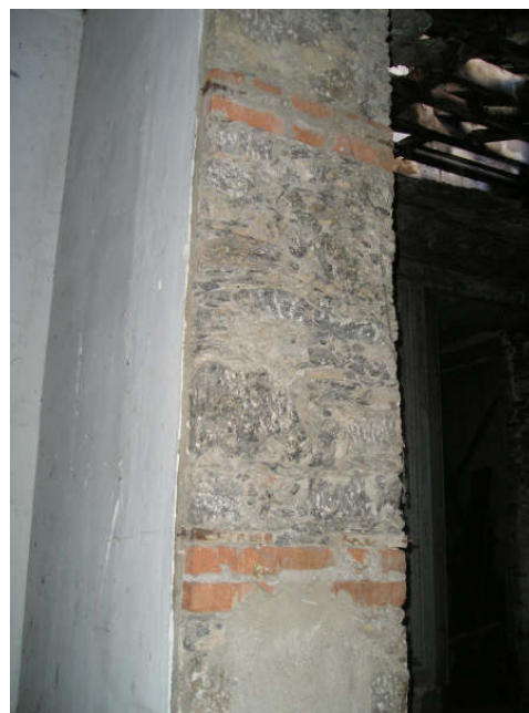
Imagem 386 – Vista do sistema construtivo de alvenaria mista com faixas de pedra e faixas tijolos maciços – foto do 1 pavimento, 2008.
