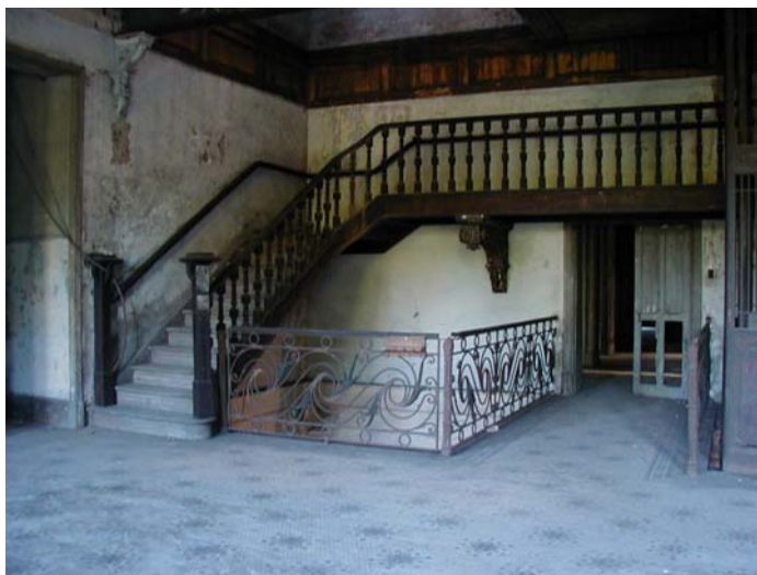
Imagem 293 – Escada do prédio principal – hall principal - 2 pavimento.
