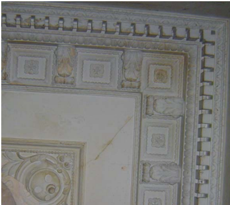
Imagem 389 – Vista do forro do ambiente de acesso com os elementos decorativos – 1 pavimento, 2005.
