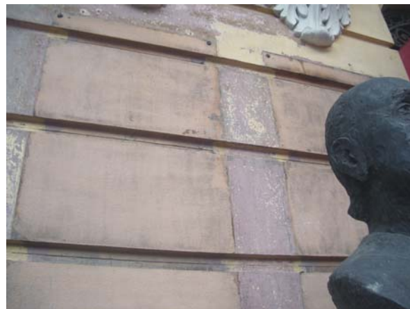
Imagem 184 – Retirada da argamassa para análise.
