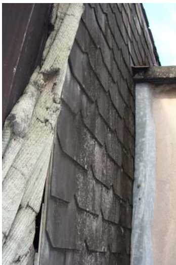
Imagem 403 – Detalhe da cobertura - fachada principal, 2008.
