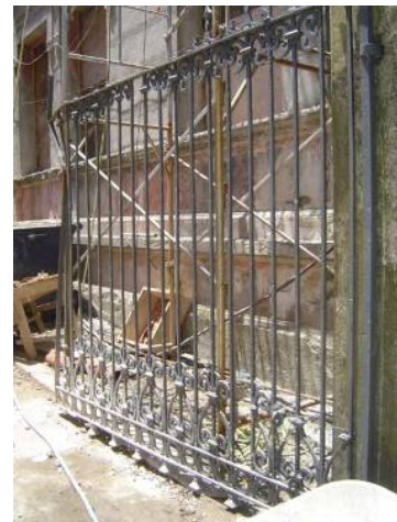
Imagem 323 – Detalhe da restauração dos gradis.
