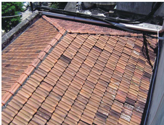
Imagem 150 – Telhado de quatro águas com telhas francesas, 2005.
