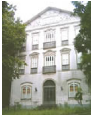
Imagem 43 – Chalet Olinda - fachada, Rio de Janeiro.
