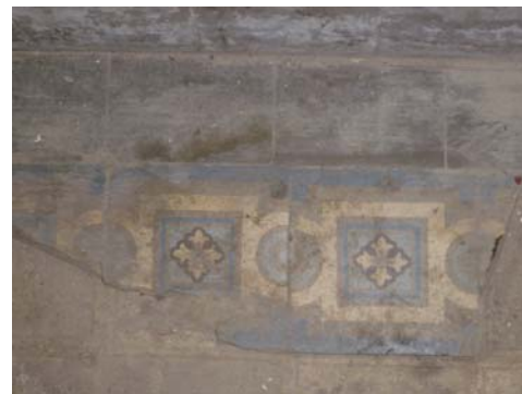
Imagem 393 – Piso da circulação em ladrilho hidráulico, 2008.
