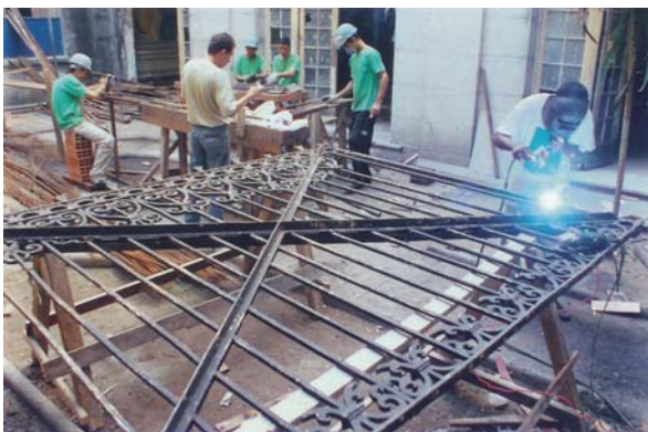
Imagem 322 – Detalhe da restauração dos gradis.
