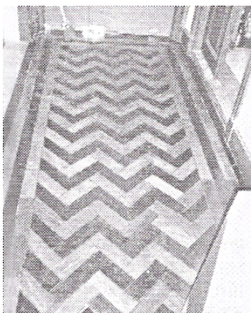
Imagem 67 – Circulação da Mansão Figner – piso em tacos de madeira em dois tons com assentamento espinhado ao centro e tabeira ortogonal formando faixas também em dois tons.
