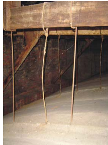
Imagem 152 – Sistema de sustentação da área do forro localizada acima do palco do Salão Leopoldo Miguez, feito através de tirantes de cabos de aço e vergalhões sustentados pelos barrotes e linhas das tesouras, 2005.
