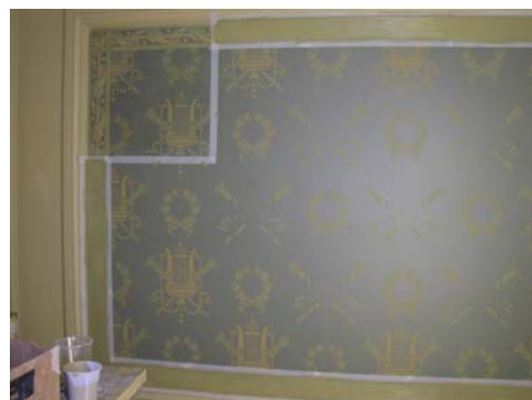
Imagem 200 – Pintura dos painéis quase acabada.
