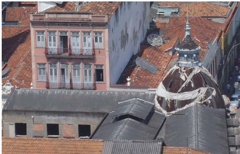
Imagem 402 – Cobertura da edificação, 2005.
