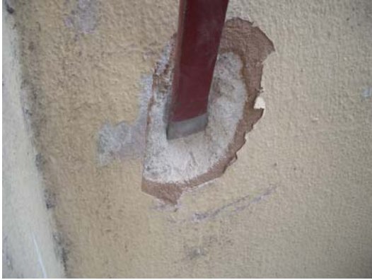
Imagem 181 – Retirada da argamassa para análise.
