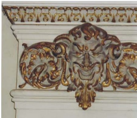
Imagem 195 – Ornato da coluna do salão – antes da restauração, 2005.
