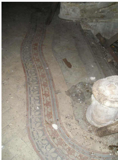
Imagem 405 – Escada de acesso, 2008.
