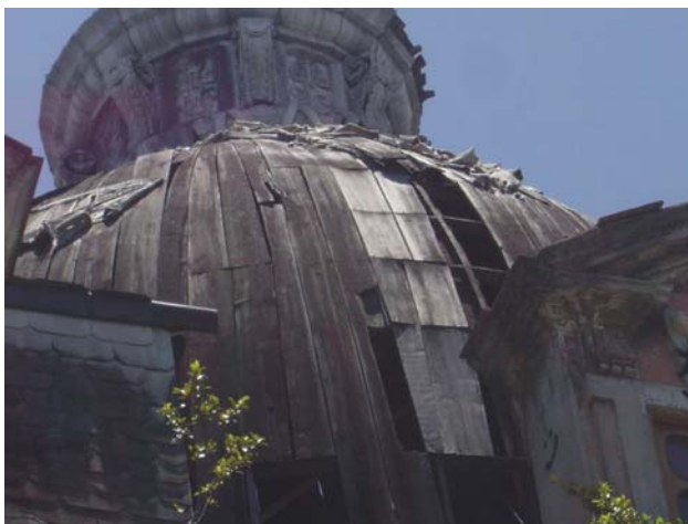
Imagem 413 – Recuperação da cúpula – vista externa, 2005.
