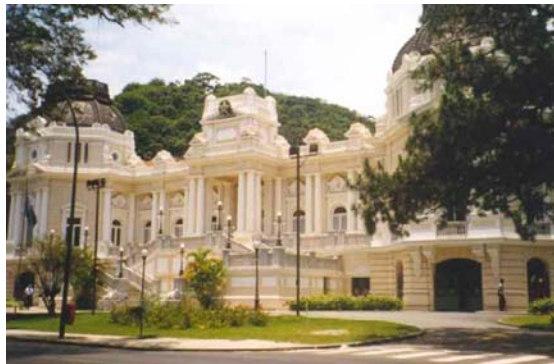
Imagem 29 – Palácio Guanabara – Exemplo de fachada descentrada, Rio de Janeiro, 1908.
