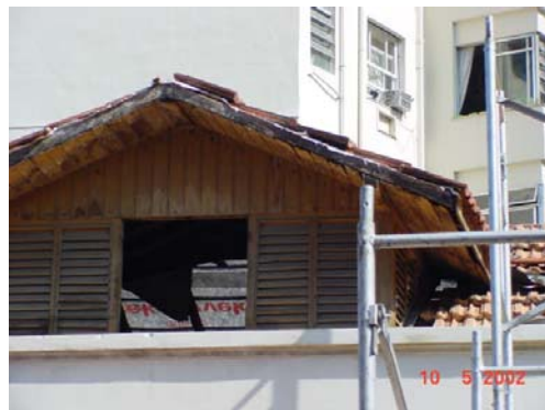
Imagem 327 – Detalhe da água-furtada - telhado do prédio Anexo.
