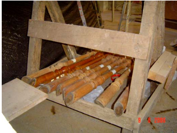
Imagem 330 – Peças da escada do hall - prédio Anexo.
