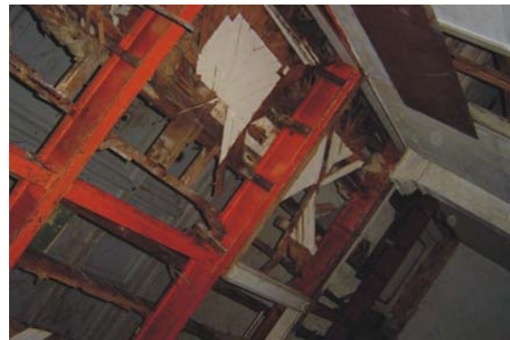
Imagem 416 – Detalhe da viga metálica de reforço estrutural instalada no prédio, 2005.
