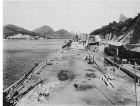
Imagem 209 – Construção da Avenida do Morro da Viúva - fase de calçamento - década de 20.
