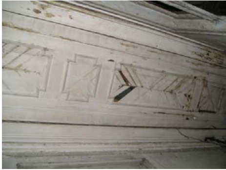
Imagem 398 – Detalhe do forro em madeira da circulação – 1 pavimento, 2005.
