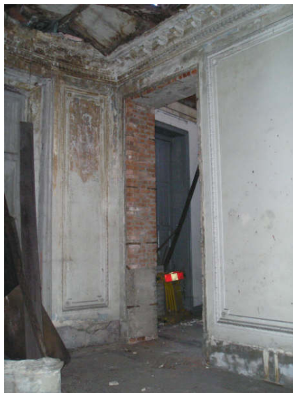
Imagem 387 – Vista das paredes com decoração em estuque – 1 pavimento, 2008.
