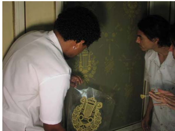
Imagem 198 – Aplicação da pintura através da sobreposição de máscaras nos painéis.
