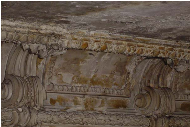
Imagem 390 – Vista da sanca existente no ambiente acima do de acesso – 2 pavimento, 2005.
