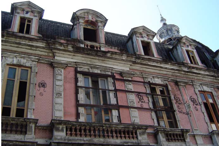
Imagem 391 – Vista dos elementos decorativos da fachada, como as colunas, detalhes ao redor das janelas, balaustrada, decoração da lanterna da cúpula, 2005.
