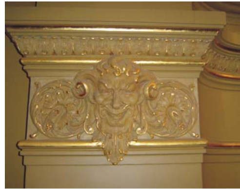
Imagem 196 – Ornato da coluna do salão – após a restauração, 2007.
