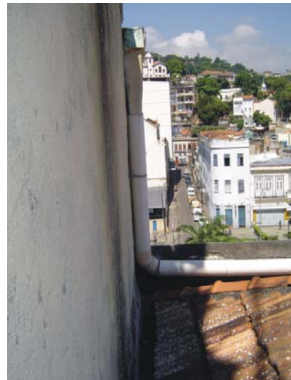
Imagem 164 - Instalações de águas pluviais correndo sobre o telhado 01 da edificação.
