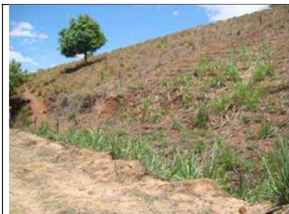
Figura 83 - Vista parcial da área selecionada 3
