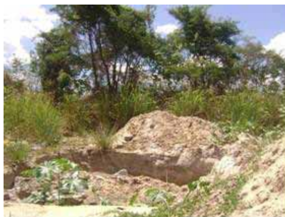
Figura 21 - Células para depósito de resíduos de serviços de saúde.
