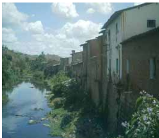
Figura 38 - Descargas de esgoto sanitário no Rio Mundaú.
