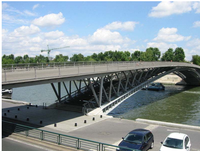
Figura 2.6: Passarela Solferino. Fonte: Dallard et al. (2001)
