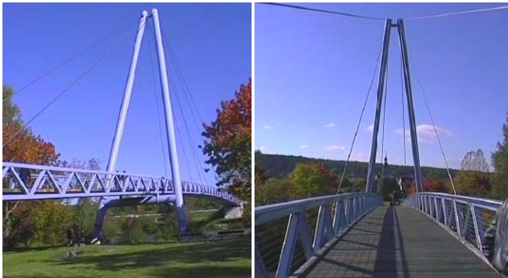
Figura 2.9: Vistas da passarela Forchheim. Fonte: Seiler et al. (2003)
