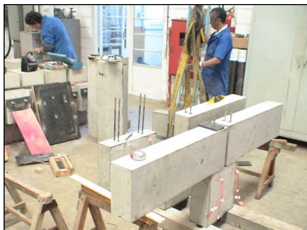
Figura 3.21 - Montagem e fixação das ligações.
