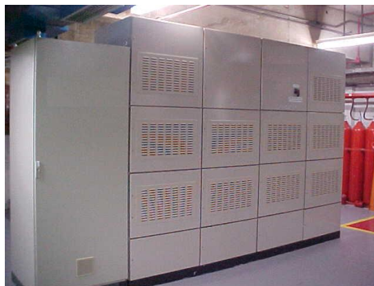
Figura 3.22: unidades de potência (retificadores) e de controle da proteção anódica, instaladas no CCM do digestor (CENIBRA, 2006)
