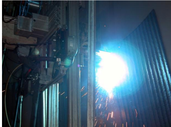
Figura 3.24: aplicação de weld overlay (CENIBRA, 2004).
