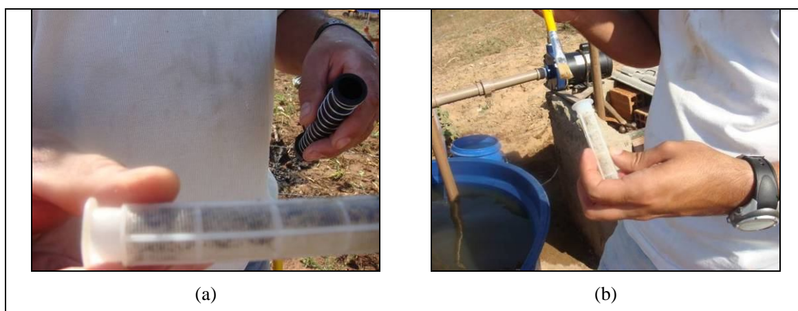
Figura 26 – Entupimento do filtro de um aspersor PS: (a) filtro entupido por partículas; e (b) limpeza do filtro.
