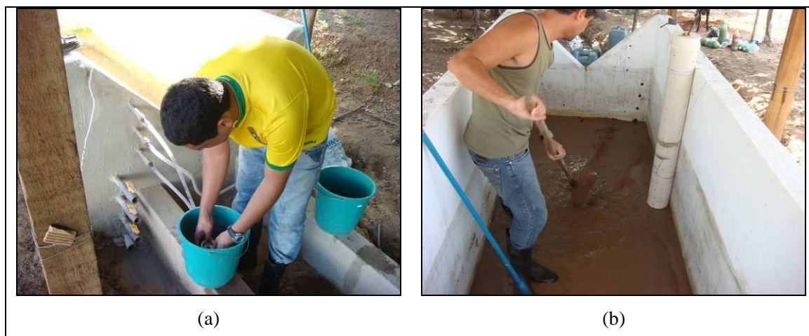
Figura 21 – Limpeza da fossa de sedimentos: (a) Lavagem dos recipientes conectados aos tubos de amostragem automática; e (b) Limpeza do fundo da fossa.
