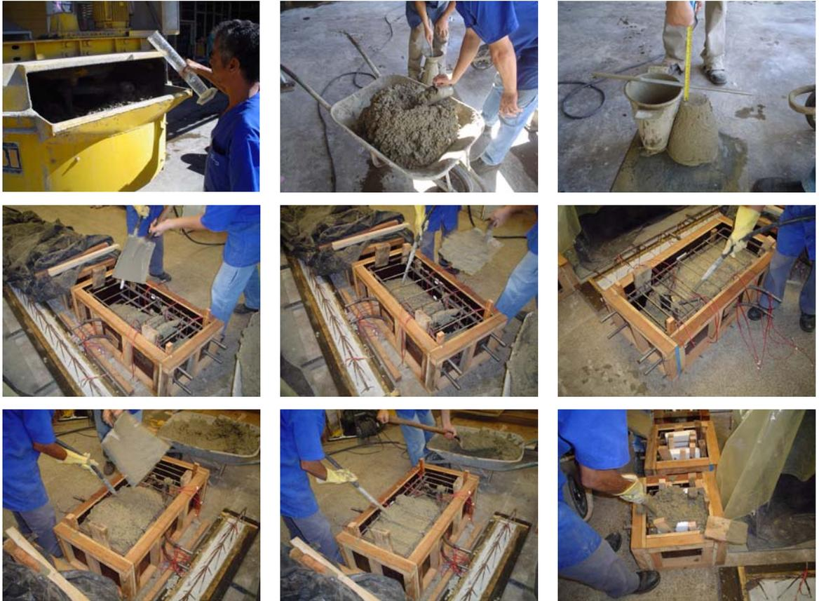
Figura 3.20: Concretagem do modelo 03.
