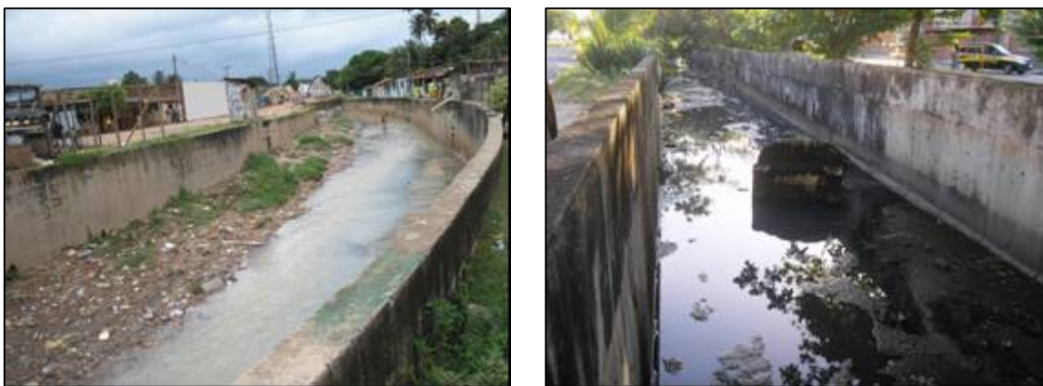
Figura 5.21. Parte do riacho Reginaldo canalizado e riacho Gulandim
