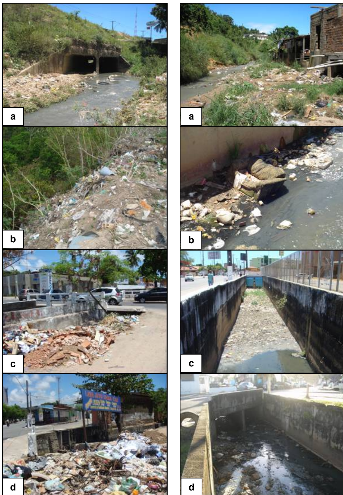
Figura 5.20. Presença de resíduos sólidos ao longo do riacho a. Pau d'Arco b. Reginaldo c. Sapo d. Gulandim
