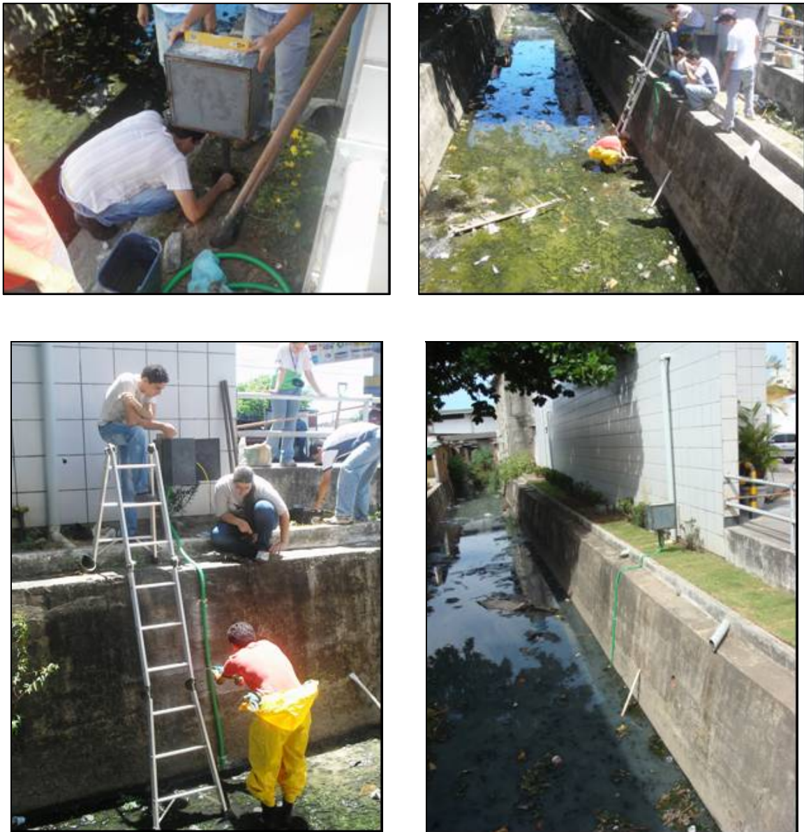
Figura 4.3. Instalação do sensor de nível
