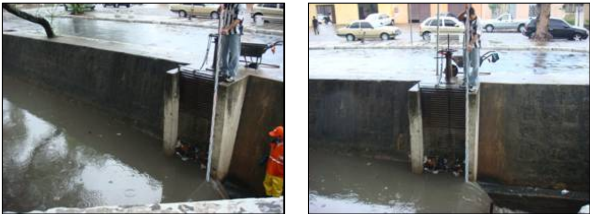
Figura 4.5. Fotografia da colocação da régua para estimativa dos níveis da água no riacho do Sapo
