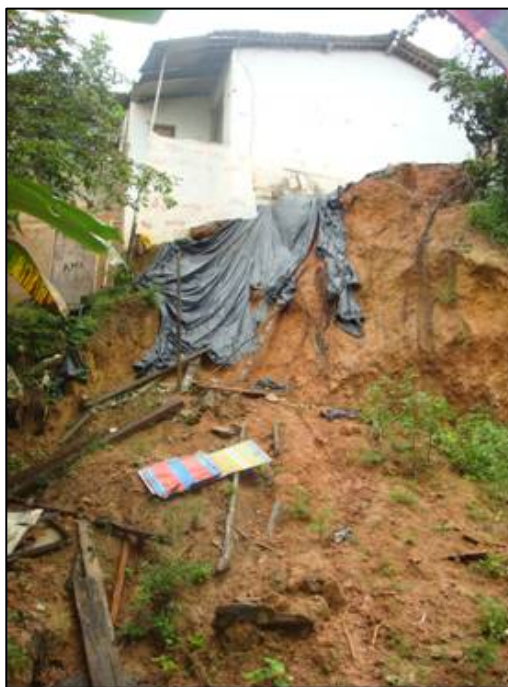
Figura 5.5. Área no vale do Reginaldo com risco iminente de deslizamento
