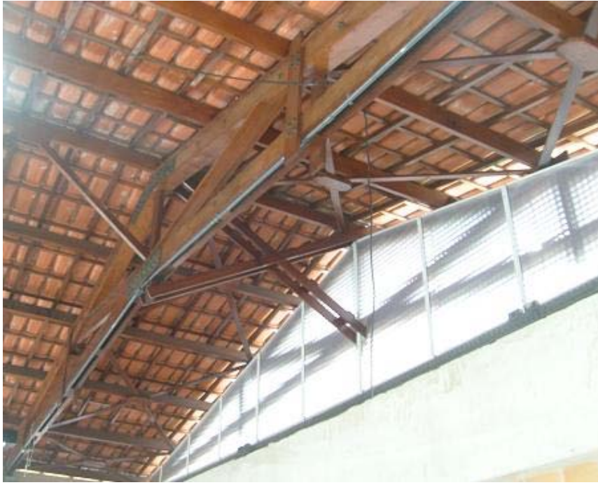
Figura 2.1 - Contraventamento de cobertura em tesouras de madeira
