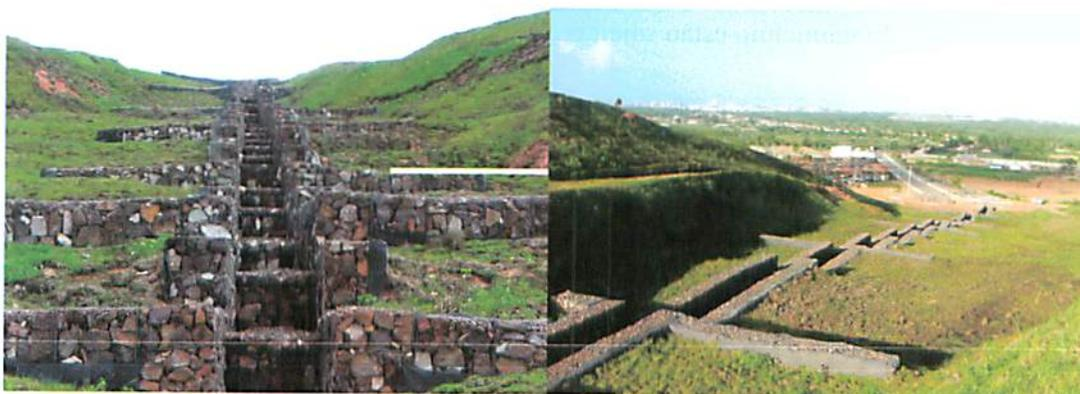
Figura 6.1: MORRO DO AVIÃO – reflorestamento e sistema de drenagem.
