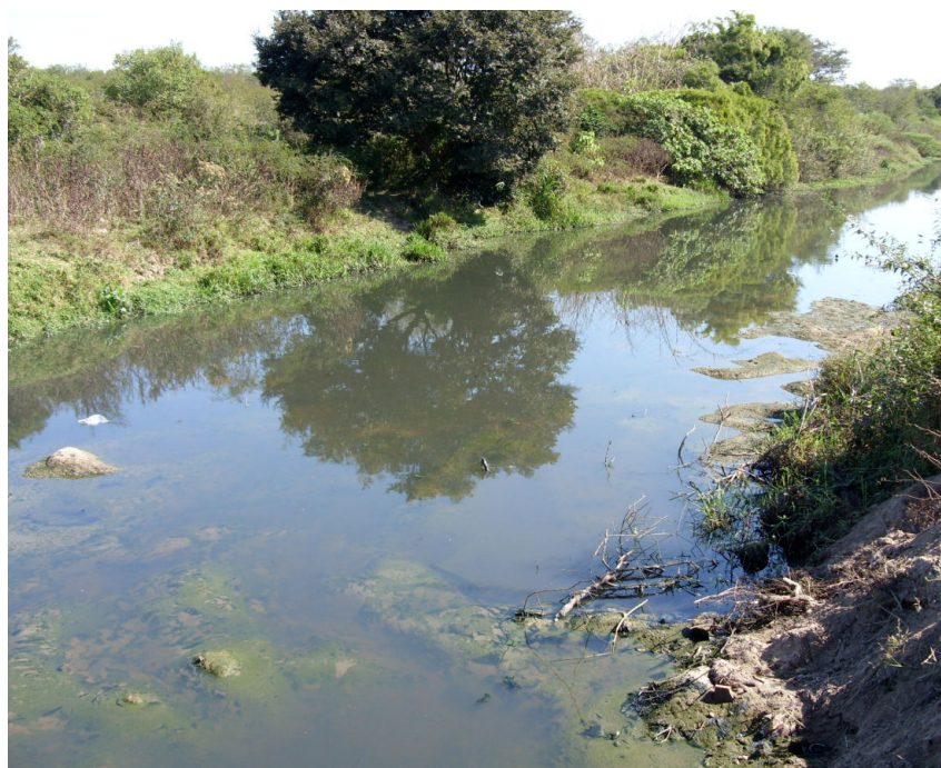
FIG. 14 - ASSOREAMENTO NO ARROIO DO SALSO (04/05/2009)
