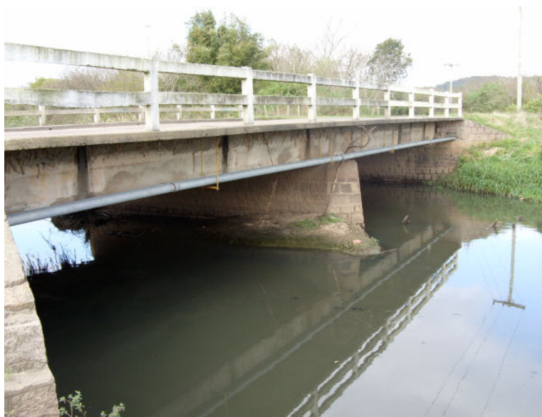
FIG. 34 – PONTE NA AVENIDA DA SERRARIA
