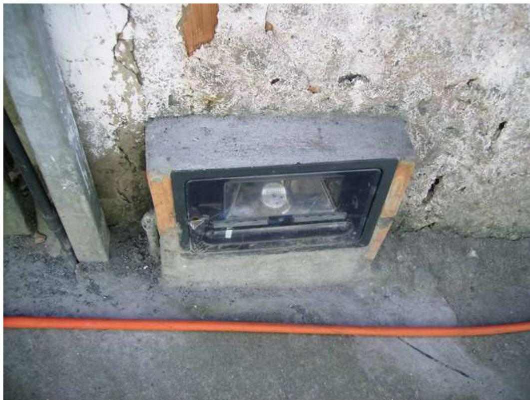
**FOTO 23: Solução adotada pelo morador para proteger o hidrômetro.**
