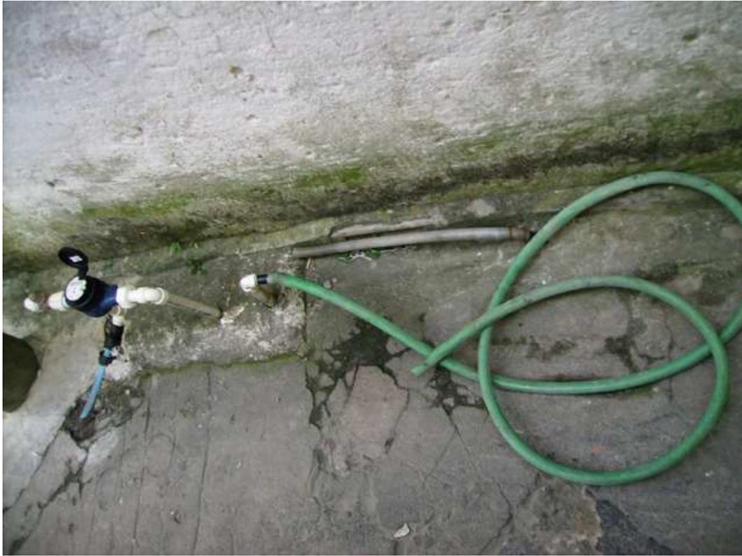
**FOTO 13: Mangueras conectadas nos hidrômetros**
