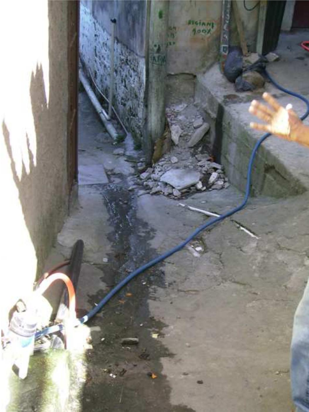
**FOTO 16:** As imagens mostram a perda da água na passagem do cano para a mangueira
