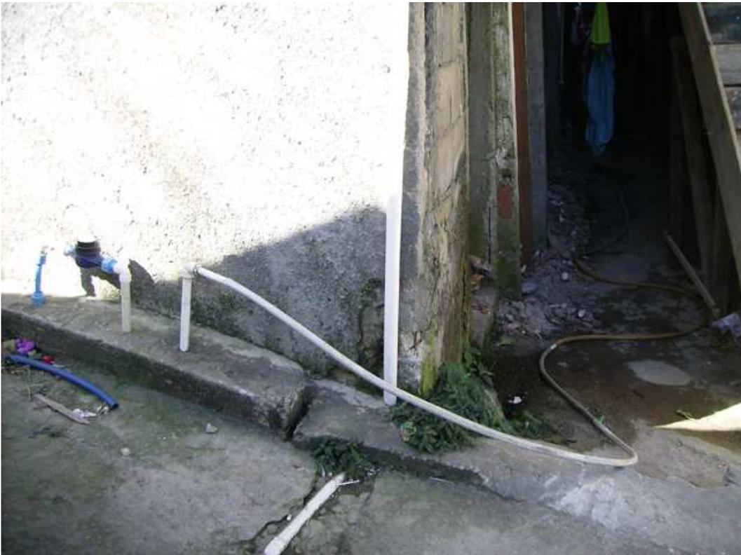
**FOTO 10: Sistema de mangueiras utilizado para captar água**
