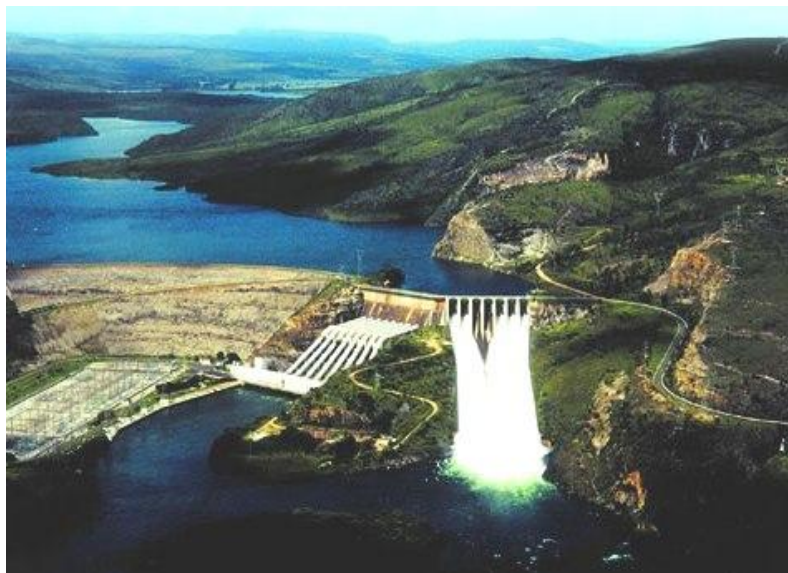
Figura 2.8 - Usina Hidrelétrica de Furnas - recente imagem aérea da usina (Furnas, 2009).
