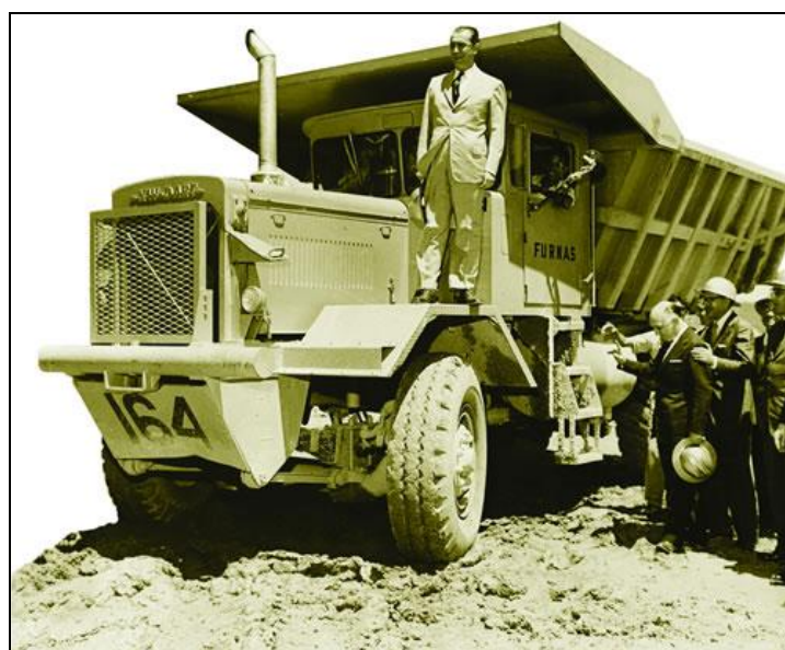
Figura 2.5 - O presidente Juscelino em uma de suas visitas às obras da Usina Hidrelétrica de Furnas (Furnas, 2009).
