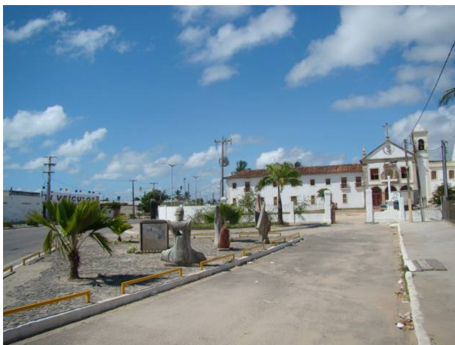
Figura 35 Convento de Santa Tereza
