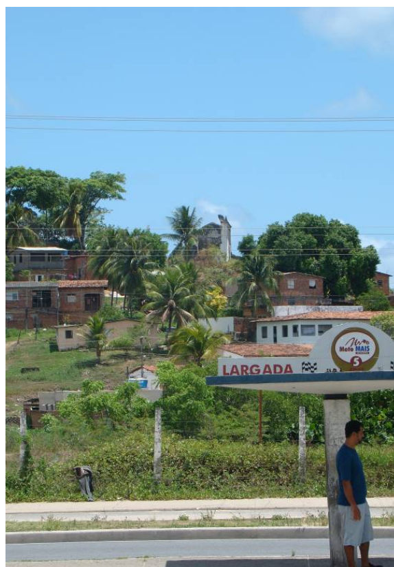
Figura 1 Ruína da Capela de Santana (ao centro) e entorno
