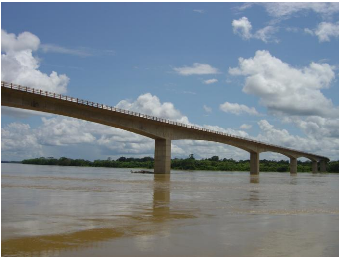
Figura 10: Ponte sobre o Rio Guaviare
