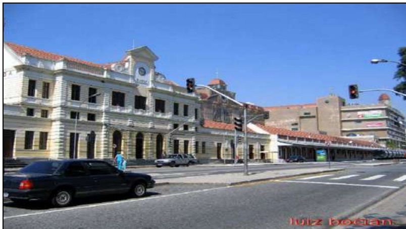
Figura 23 – Panorâmica frontal do Museu ferroviário que abriga a antiga estação de trem de Curitiba, inaugurada em 1885 com a finalidade de servir à linha Curitiba-Paranaguá. A linha continuou em 1891, para alcançar Ponta Grossa em 1894, e depois o restante do Paraná. Em 1909, foi inaugurada a sua ligação com as cidades de São Paulo, Rio de Janeiro, mediante a junção do ramal de Itararé, da Sorocabana e da linha Itararé-Uruguaí, na estação São Pedro do Itararé. No ano seguinte, por Marcelino Ramos-SC, seria possível também se viajar de Curitiba a Porto Alegre de trem. (GIESBRECHT, 2007).
