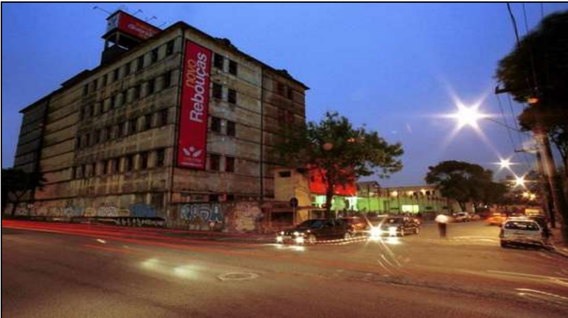
Figura 15 – Vista panorâmica do antigo prédio do Moinho Rebouças, atual sede da Fundação Cultural de Curitiba. Localiza-se à Rua Engenheiros Rebouças, no bairro Rebouças, próximo ao Espaço Estação. O prédio foi construído por ingleses, na década de 1930, para produção de farinha de trigo, farelo e biscoitos. Sofreu um incêndio em 1942 e só voltou a funcionar depois de se tornar sede da Fundação Cultural, em 2001, como parte do projeto de refuncionalização do bairro. O espaço foi doado ao município mediante leis de incentivo à preservação do patrimônio histórico da cidade. O bairro recebeu esse nome em homenagem aos engenheiros, irmãos Antônio e André Rebouças, que no final do século XIX chegaram ao Paraná para construir a estrada de ferro Curitiba-Paraná, em atividade até os dias de hoje. (GAZETA DO POVO, 2006. p. 1)
