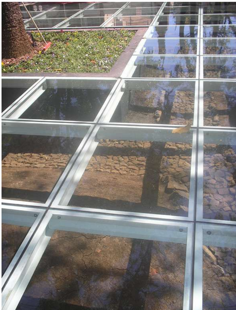
Figura 19 – Vista parcial da Praça Tiradentes, com detalhe de calçada histórica, fotografada em 2008. Na realização das obras na Praça Tiradentes foi encontrado uma calçada, que os arqueólogos acreditam ser da segunda metade do século XIX, e objetos como faca, cartucho, cerâmica, vestígios dos primeiros moradores de Curitiba. Sobre a calçada foi colocada um piso de vidro laminado de 119 m 2 para visitação turística.
