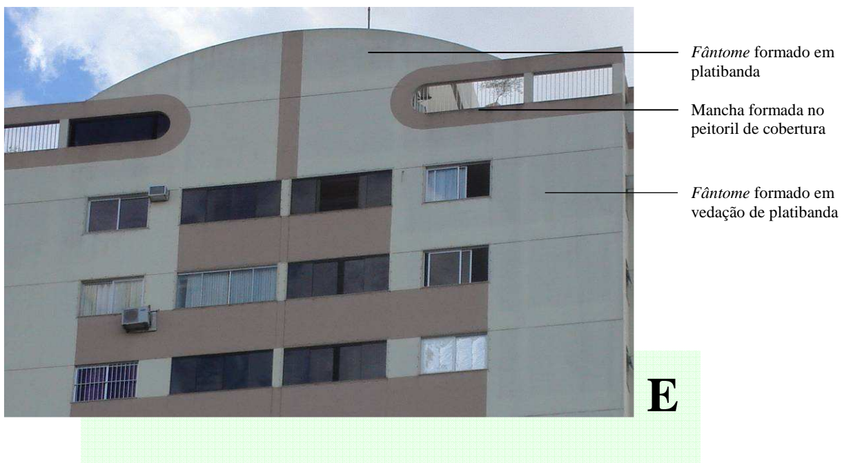
Figura 5.24 - Fachada Leste do edifício 1
