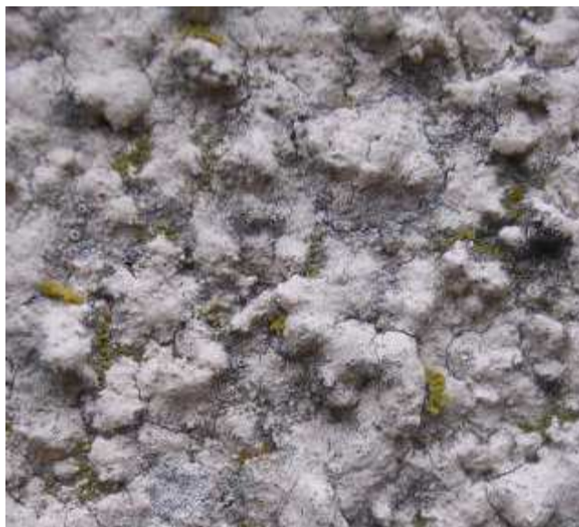
Figura 3.10 - Revestimento de fachada com pelo menos cinco espécies diferentes de líquenes (JOHANSSON et al. , 2005)
