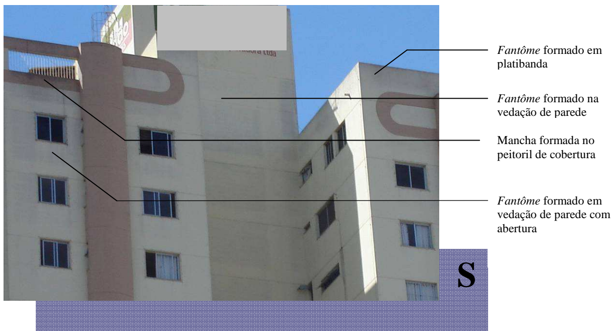
Figura 5.23 - Fachada Sul do edifício 1
