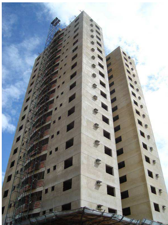
Figura 4.5 - Edificação onde foram realizadas as medições de umidade
