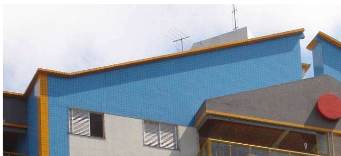
Figura 5.56 - Detalhe da platibanda
