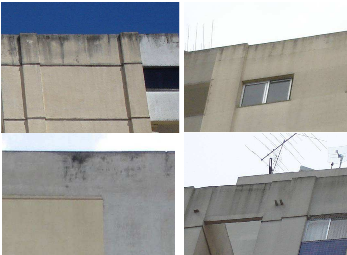
Figura 5.75 - Manchas escuras, provavelmente oriundas da formação de microorganismos
