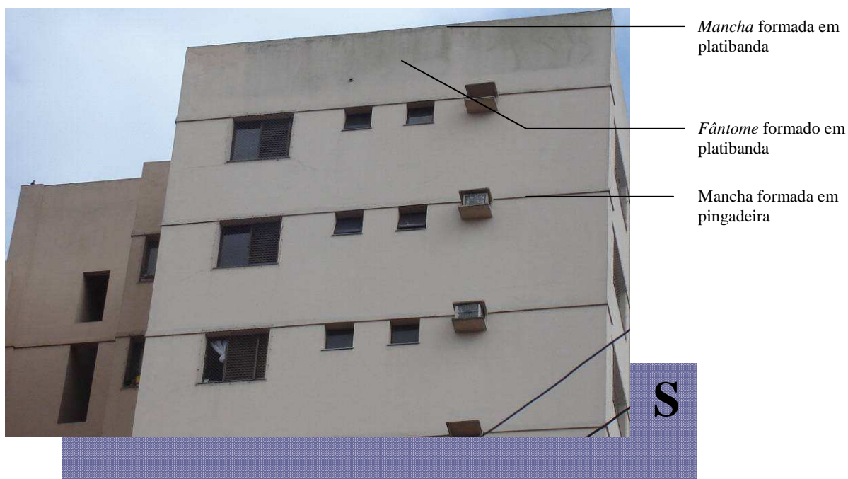
Figura 5.32 - Fachada Sul do edifício 2
