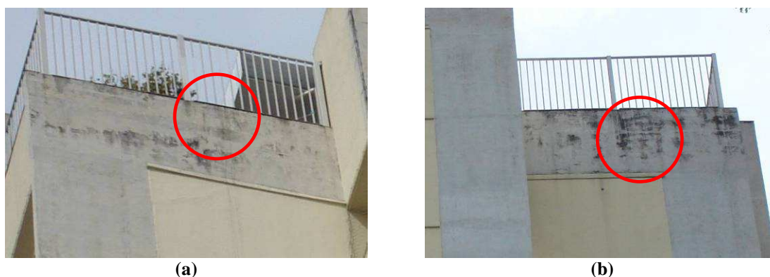
Figura 5.79 - Fachada Norte (a) e fachada Sul
