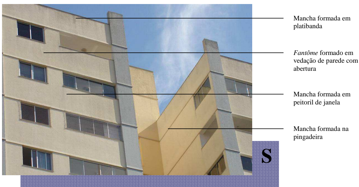
Figura 5.50 - Fachada Sul do edifício 4
