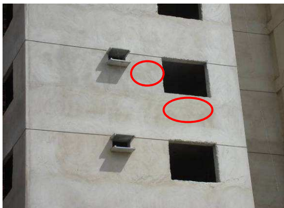
Figura 4.8 - Regiões da fachada (embaixo e ao lado da abertura da janela) onde foram realizadas as medições de umidade
