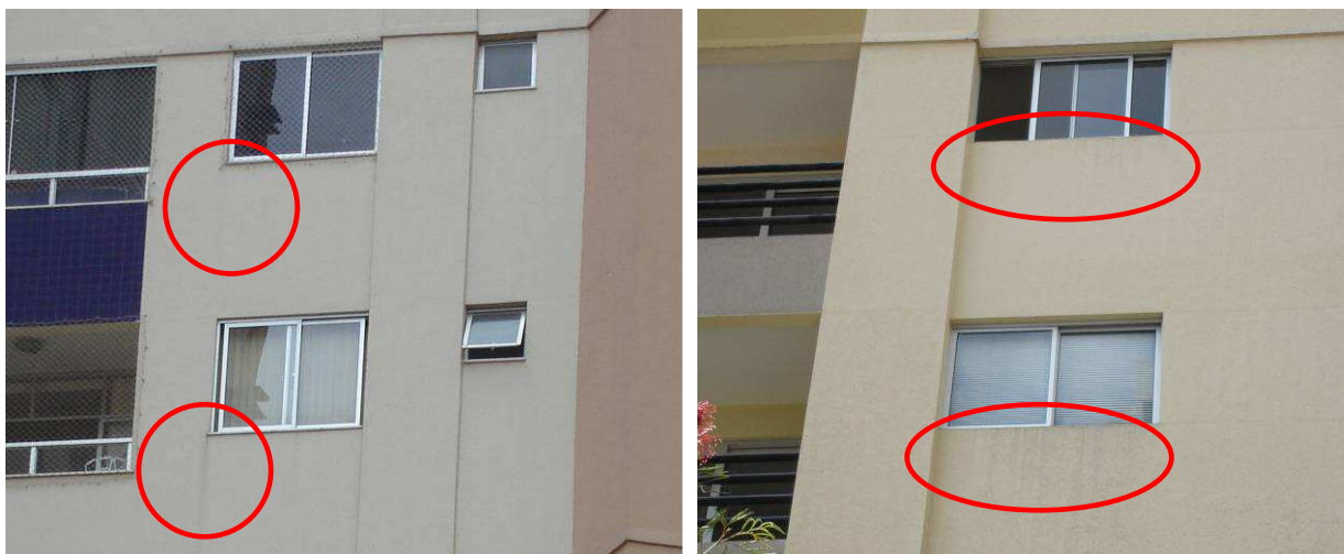
Figura 5.69 - Proteção proporcionada por pingadeiras no escoamento da água sobre a fachada
