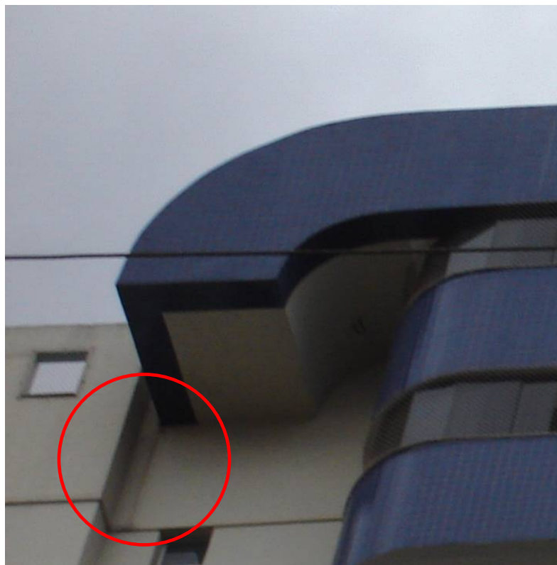
Figura 5.78 - Formação de manchas pelo escoamento preferencial da água
