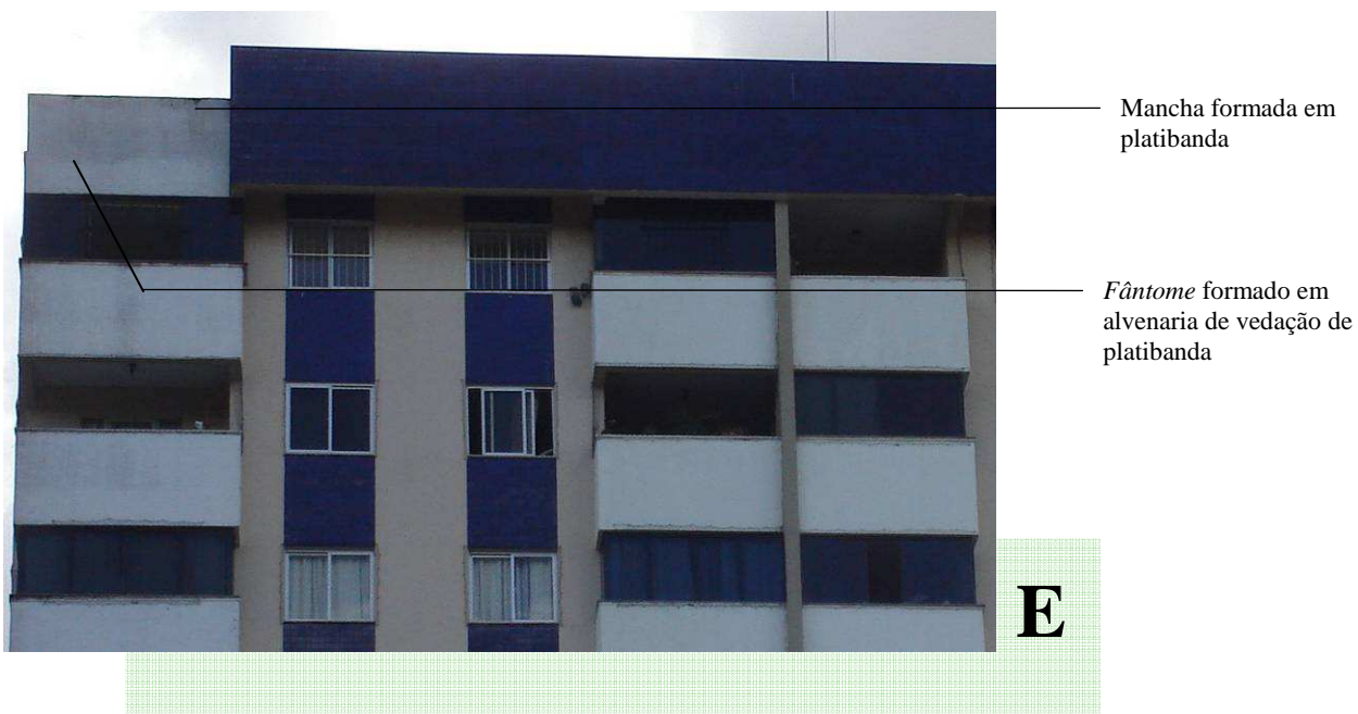
Figura 5.43 - Fachada Leste do edifício 3
