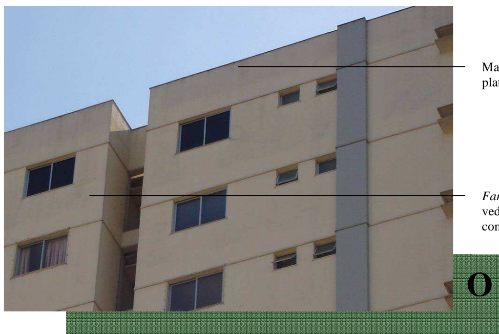
Figura 5.52 - Fachada Oeste do edifício 4
