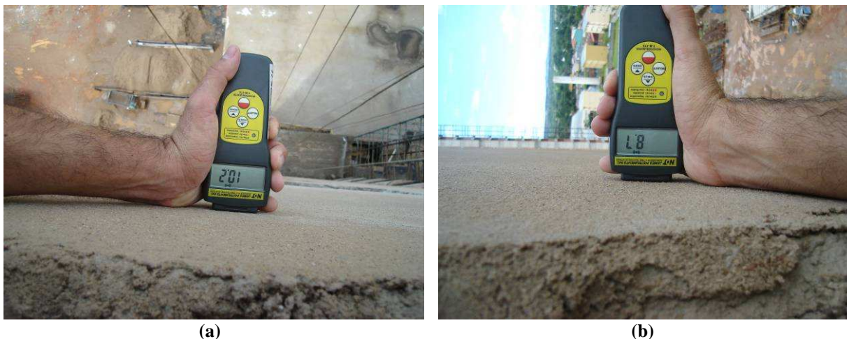
Figura 4.6 - Medição realizada na fachada Norte do 9º andar, embaixo da janela (a) e ao lado da janela (b), próximo à fachada Oeste
