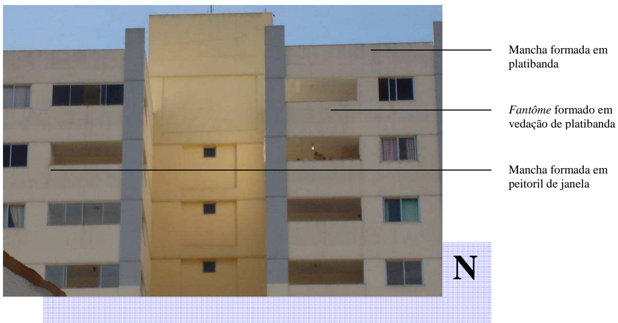
Figura 5.49 - Fachada Norte do edifício 4
