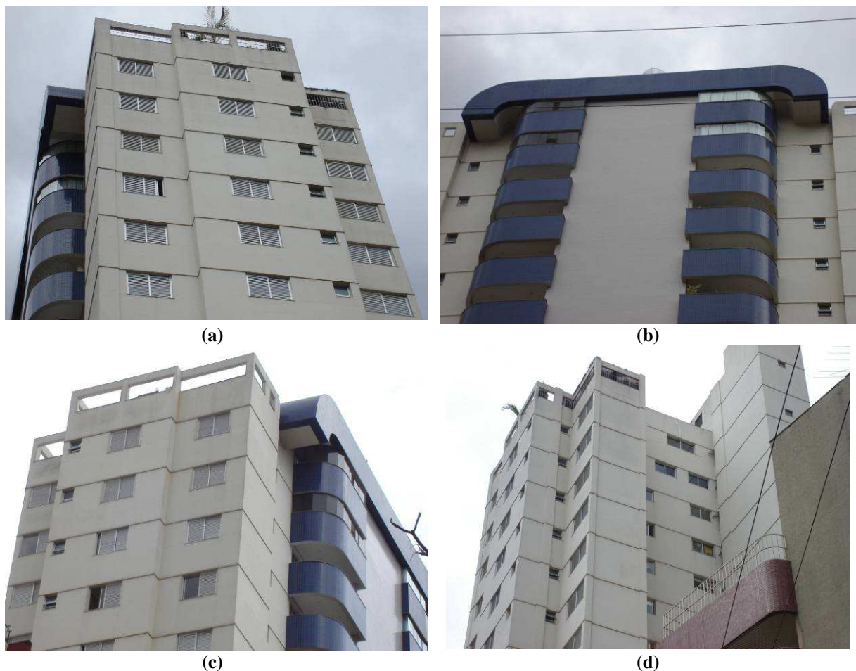
Figura 4.12 - Fachadas de um mesmo edifício: Orientação N (a), L (b), S (c) e O (d)
