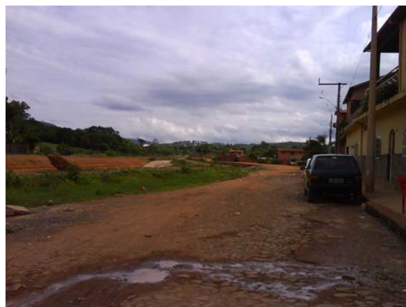
FIGURA 17 - Avenida 'B', situada à margem do Córrego dos Mangues AUTORA: CASTRO, G. F.; 19/01/2009
