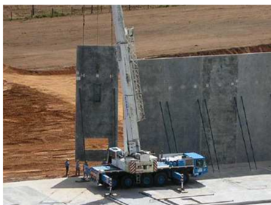
Figura 4. Colocação do painel para local definitivo. Fonte: Pereira, 2002.
