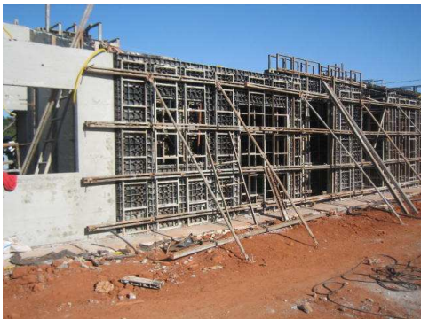
Figura 54. Fechamento da fôrma e escoramento. Fonte: BEZERRA, 2008.
