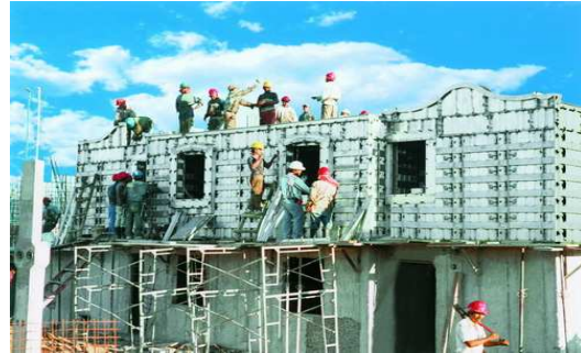
Figura 8. FORSA FORMALETAS – Montagem das fôrmas. Fonte: FORSA FORMALETAS, 2007.
