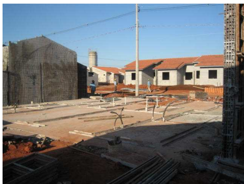
Figura 48. Fundação em radier. Fonte: Bezerra, 2008.
