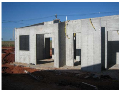
Figura 60. Vedações finalizadas prontas para receber esquadrias e acabamentos Fonte: BEZERRA, 2008.
