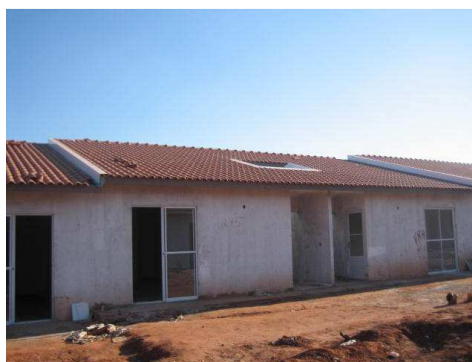
Figura 64. Colocação das telhas tipo Portuguesa. Fonte: BEZERRA, 2008.
