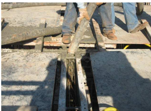
Figura 26. Concretagem auxiliada por andaimes – São José do Rio Preto-SP. Fonte: BEZERRA, 2008.
