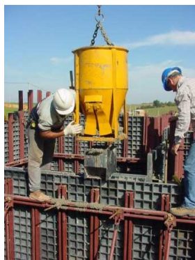
Figura 28. Detalhe da concretagem com auxílio de guindaste - Monte Mor-SP Fonte: ROSSIGNOLO, 2006.
