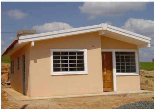
Figura 34. Habitação concluída em Monte Mor-SP Fonte: ROSSIGNOLO, 2005.
