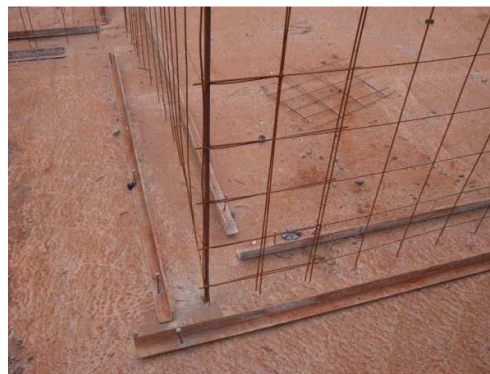
Figura 17. Detalhe da armadura nas cantoneiras Fonte: BEZERRA, 2008.
