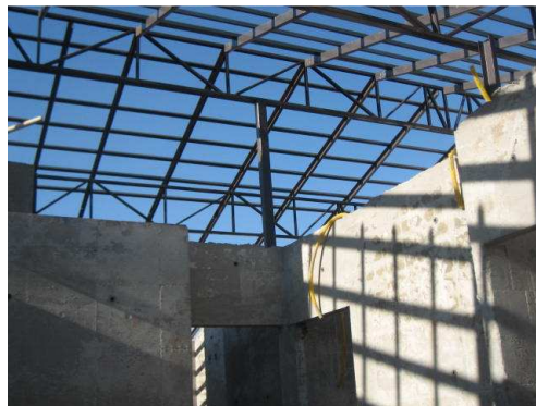
Figura 33. Detalhe do telhado com estrutura metálica. Fonte: BEZERRA, 2008.
