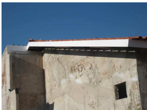
Figura 65. Detalhe do acabamento da cobertura. Fonte: BEZERRA, 2008.
