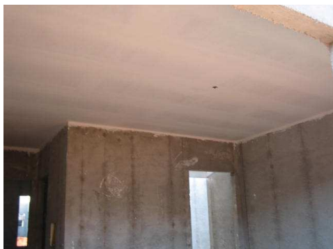
Figura 69. Aplicação de forro de gesso. Fonte: BEZERRA, 2008.
