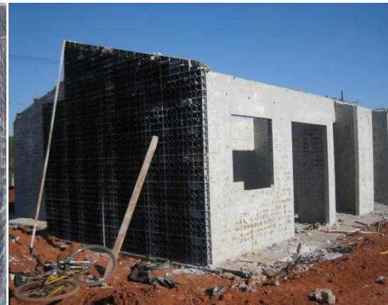
Figura 10. Vedações com fôrmas de plástico. Fonte: RODOBENS, 2008
