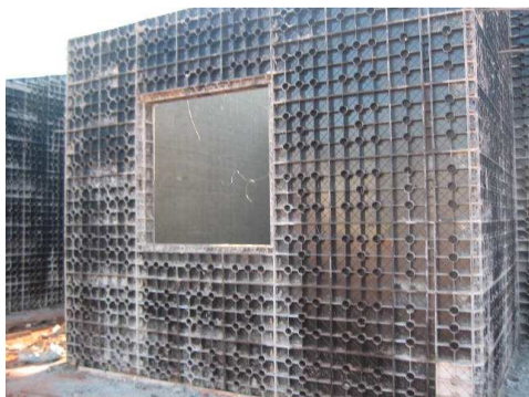
Figura 57. Preparação para a retirada das fôrmas (retirada dos escoramentos). Fonte: BEZERRA, 2008.
