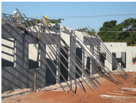
Figura 61. Início de montagem da cobertura metálica Fonte: BEZERRA, 2008.
