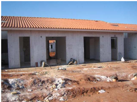
Figura 67. Habitação pronta para receber esquadrias. Fonte: BEZERRA, 2008.
