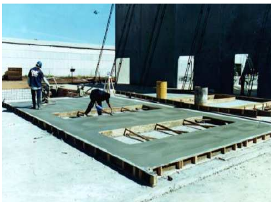
Figura 1. Execução de painel horizontal Fonte: Pereira, 2002.
