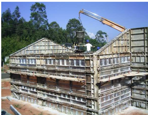
Figura 20. Sistema de fôrmas metálicas - Santa Maria da Serra-SP Fonte: ROSSIGNOLO, 2006.
