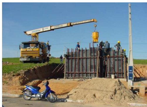
Figura 27. Guindaste utilizado na concretagem. Monte Mor-SP Fonte: ROSSIGNOLO, 2006.
