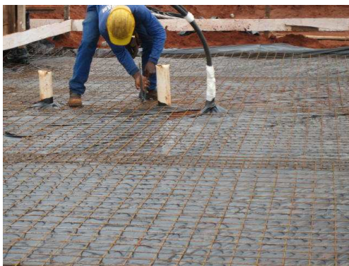
Figura 14. Detalhe da armadura e ponto de tubulação.
