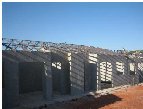
Figura 62. Finalização da montagem da estrutura da cobertura Fonte: BEZERRA, 2008.
