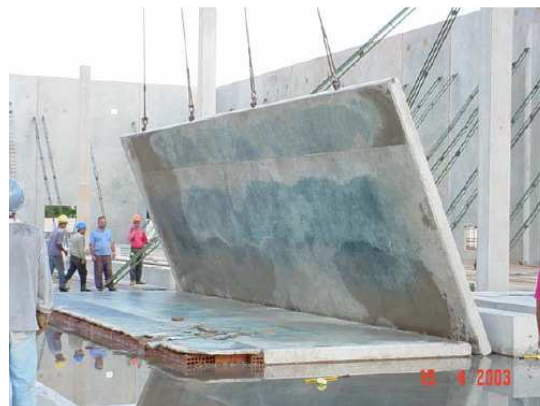
Figura 2. Içamento do painel. Fonte: Pereira, 2002
