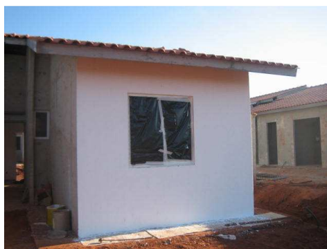
Figura 72. Pintura externa com textura. Fonte: BEZERRA, 2008.
