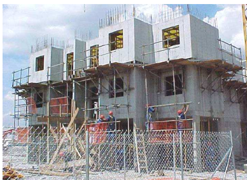
Figura 5. INPAR - Edifício multipavimentos, executado com fôrmas.
