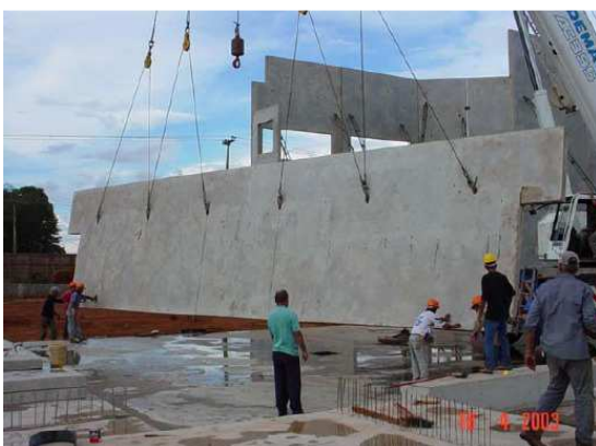
Figura 3. Içamento do painel e colocação no local definitivo. Fonte: Pereira, 2002.
