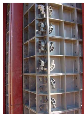
Figura 23. Detalhe dos grampos utilizados para encaixe – Mont Mor-SP. Fonte: ROSSIGNOLO, 2005.
