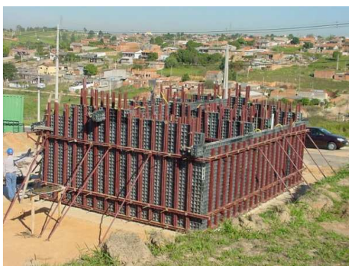
Figura 22. Sistemas de fôrmas de plástico - Mont Mor-SP. Fonte: ROSSIGNOLO, 2005.
