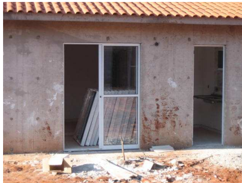
Figura 68. Colocação das esquadrias de alumínio. Fonte: BEZERRA, 2008.
