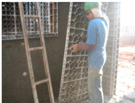
Figura 58. Retirada das fôrmas. Fonte: BEZERRA, 2008.
