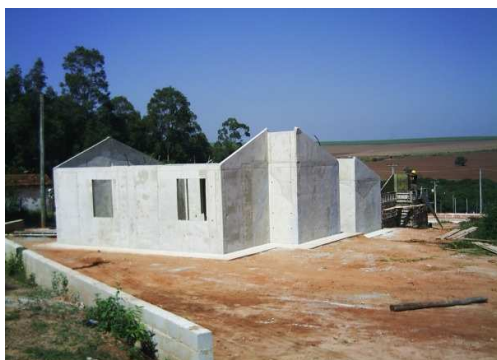
Figura 30. Retirada das Fôrmas após concretagem – Santa Maria da Serra – SP. Fonte: ROSSIGNOLO, 2005.
