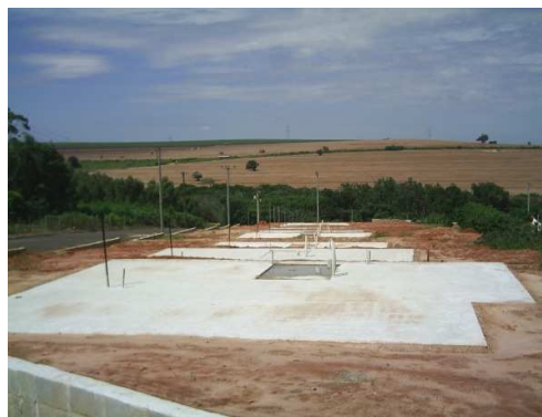
Figura 15. Detalhe do radier concretado com instalações.
