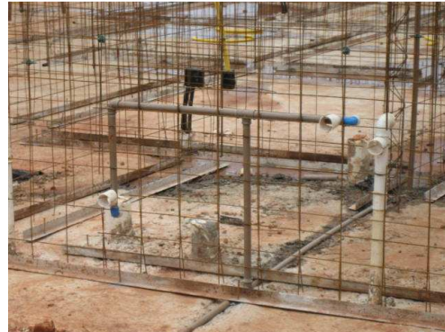
Figura 19. Detalhe das instalações hidráulicas Fonte: BEZERRA, 2008.
