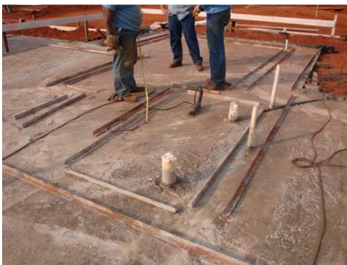
Figura 16. Detalhe das cantoneiras Fonte: BEZERRA, 2008.
