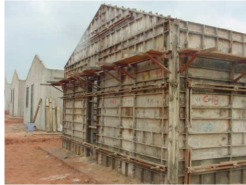
Figura 13. Habitações térreas executadas com sistema de fôrmas metálicas. Fonte: ROSSIGNOLO, 2005.
