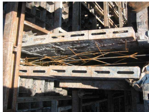
Figura 55. Fôrmas de vedação e estrutural: detalhe da armadura (vista superior do interior da fôrma) Fonte: BEZERRA, 2008.
