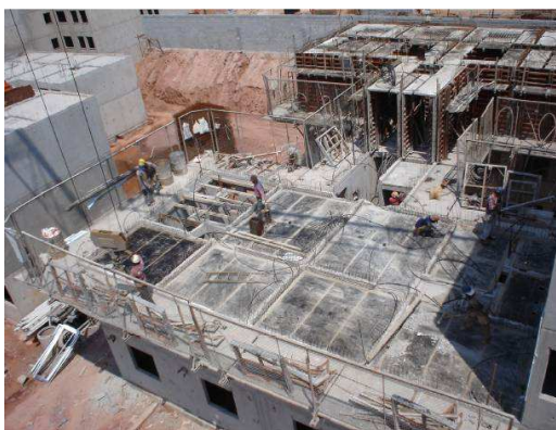
Figura 6. SERGUS - Edifício multipavimentos, escoramento e posicionamento das fôrmas.
