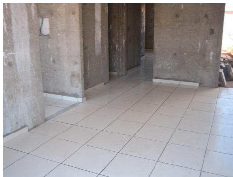
Figura 70. Aplicação da cerâmica Fonte: BEZERRA, 2008.
