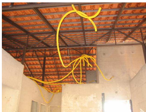
Figura 66. Cobertura: vista interna Fonte: BEZERRA, 2008.
