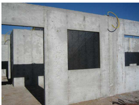
Figura 59. Vedações finalizadas prontas para receber esquadrias e acabamentos. Fonte: BEZERRA, 2008.
