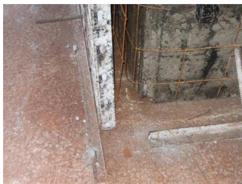
Figura 51. Fôrmas de vedação: detalhe da fixação dos painéis. Fonte: BEZERRA, 2008.
