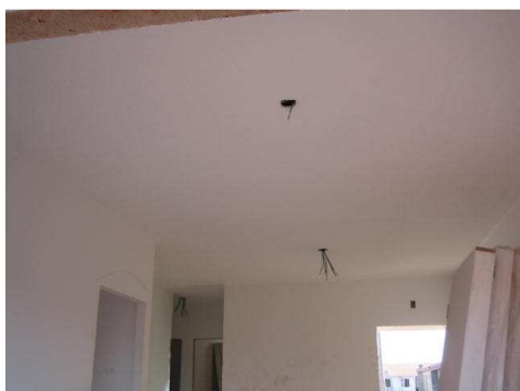
Figura 71. Pintura interna. Fonte: BEZERRA, 2008.
