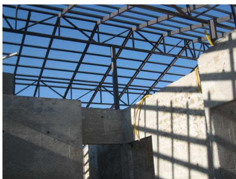
Figura 63. Vista interna da cobertura metálica. Fonte: BEZERRA, 2008.
