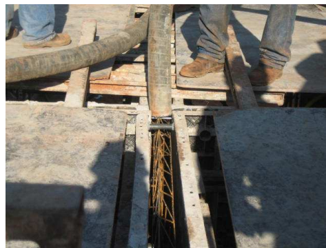
Figura 56. Preparação para concretagem das vedações verticais Fonte: BEZERRA, 2008
