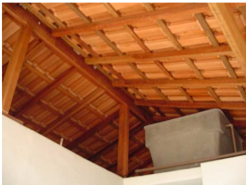
Figura 32. Detalhe do telhado em madeira com telhas cerâmicas. Analândia-SP. Fonte: ROSSIGNOLO, 2005.
