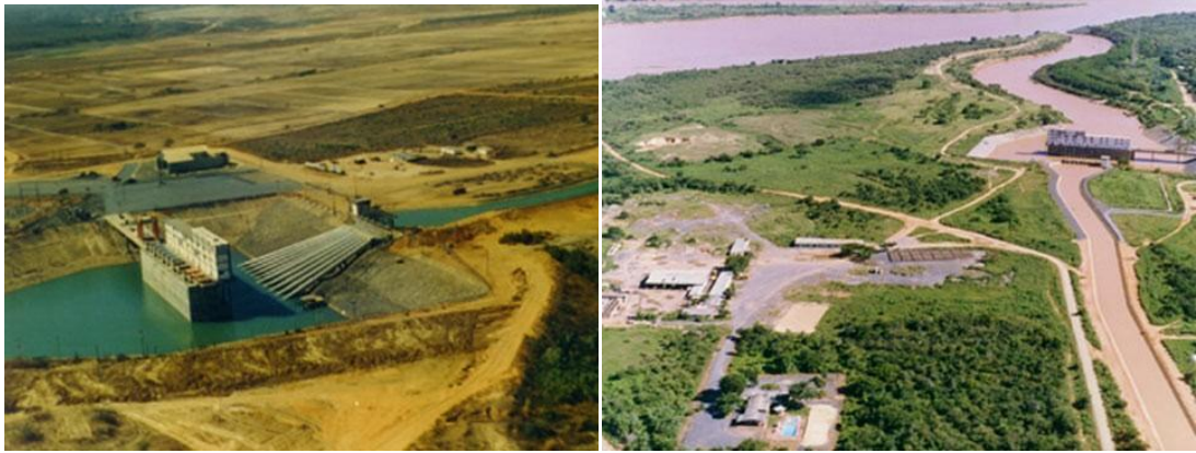
Figura 2.2 – Estação de bombeamento 1 – Vista aérea.
