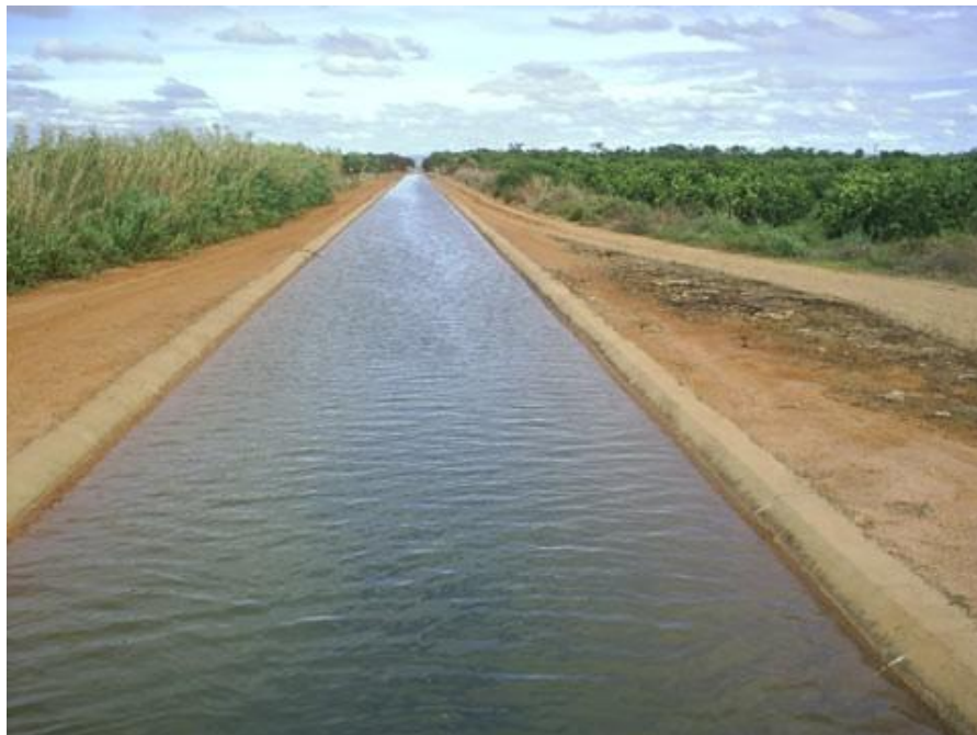
Figura 2.3 – Canal de transporte de água.
