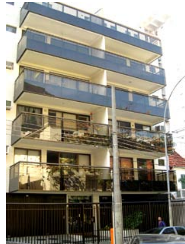
Edifício no Bairro Peixoto com 15 metros de altura.
