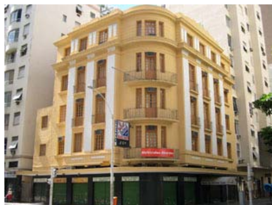
Edifício em Copacabana, na Rua Duvivier, da década de 1920. *
