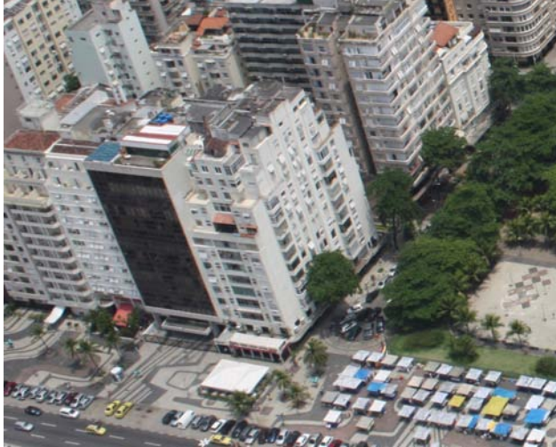
Figuras 104: Edifício no Lido com escalonamento, conforme o decreto de 1937. Fonte: Quapá, 2008.
