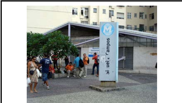
Estação Siqueira Campos, implantada na rua de mesmo nome. Foto: David Cardeman, 2009.
