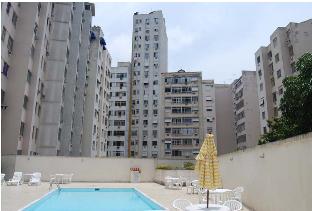
Figura 213: Foto de dentro da área de lazer do edifício. Fonte: Autor, 2009.
