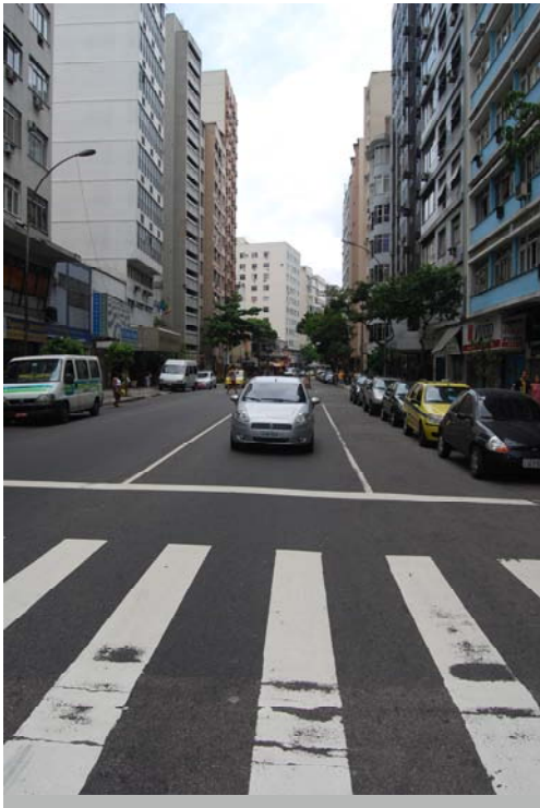
Figura 171: Rua Barata Ribeiro. A relação entre a largura da rua e a altura das edificações é menor do que 1, e a arborização é rara. Fonte: Autor, 2009.
