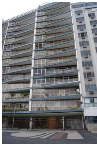
Figura 133: Exemplo de Pilotis Fechado. Fonte: Autor, 2009.
