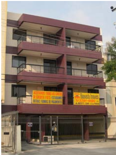
Prédio encostado nas divisas com 12 metros de altura na Av. 24 de Maio.*
