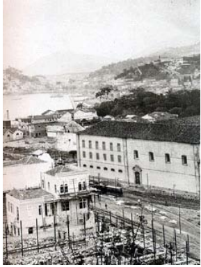
Abertura da Avenida Central. Foto: Augusto Malta, 1905.
