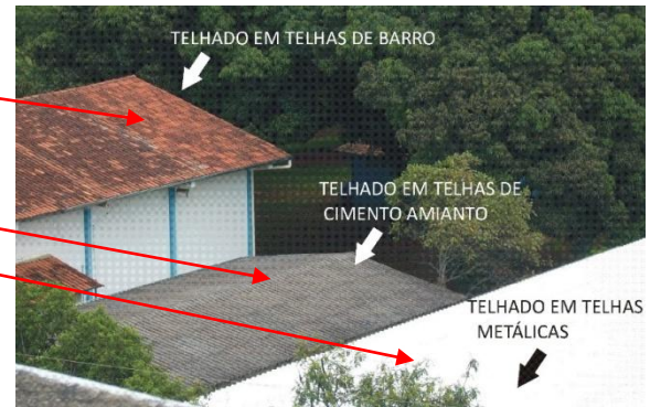
Figura 30 - Vista aérea posterior dos telhados
