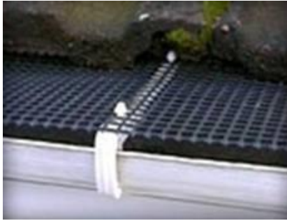
Figura 17 – Sistemas de retenção de sólidos grosseiros por meio de grade sobre a calha Fonte: Guttergrid (2009)
