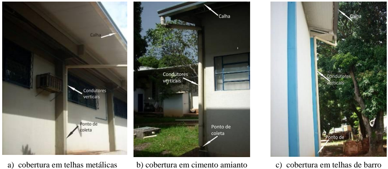
Figura 34 - Disposição das calhas nas edificações
