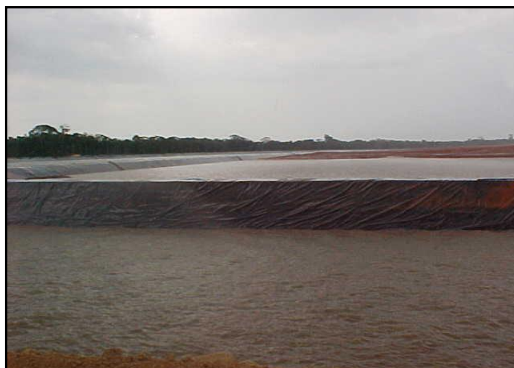
Figura 3.8 - Bacia de disposição de lama vermelha com acúmulo de água de precipitação pluviométrica.
