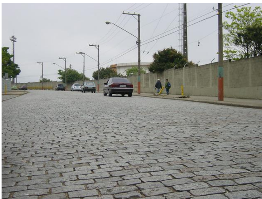
Figura 3.12 – Trecho de Pista de Paralelepípedos (Simulação de Aspereza)
