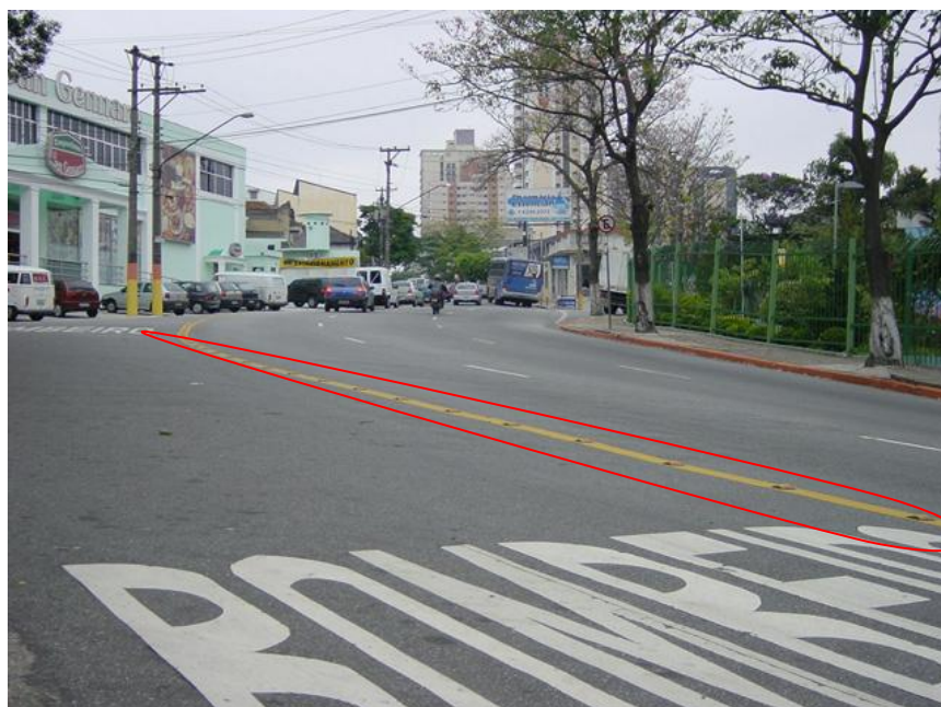
Figura 3.13 – Trecho de Pista com Olhos de Gato (Simulação de Capacidade de Absorção)
