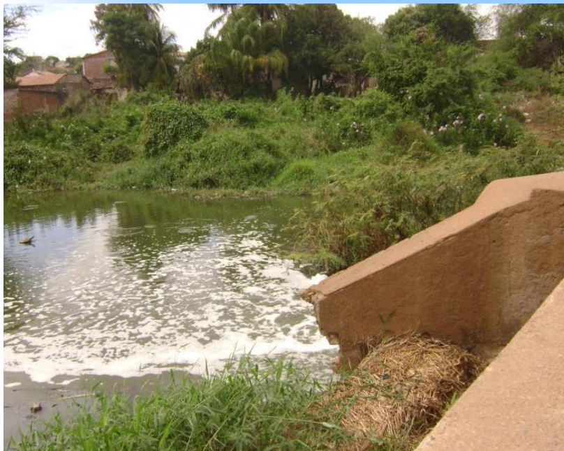
Figura 4– Lançamento de esgoto doméstico in natura no Rio do Antônio – Brumado-BA
