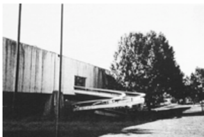
Figura 197. Rampa leste demolida na reforma.
