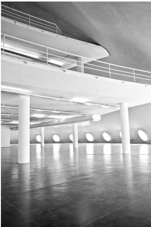
Figura 53. Palácio das Artes – estrutura arbórea independente.
