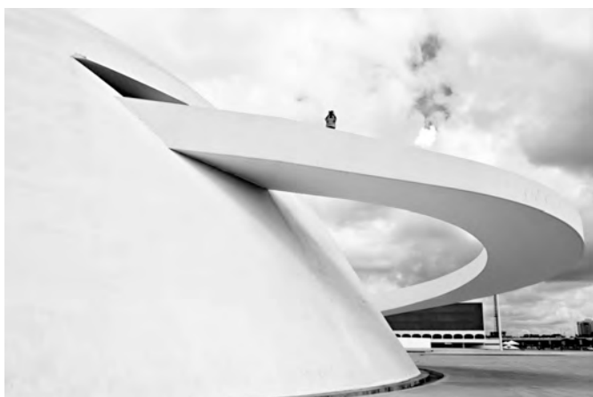
Figura 187. Museu de Brasília – rampa externa em forma de alça.
