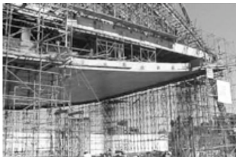
Figura 211. Museu Oscar Niemeyer – construção da viga longitudinal de 70 metros.
