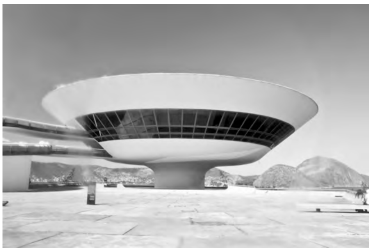
Figura 152. Museu de Arte Contemporânea de Niterói – equilíbrio das faixas de concreto e vidro.
