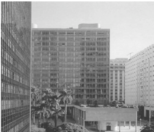
Figura 4. Ministério de Educação e Saúde, Rio de Janeiro (1936-1942). Caixa do elevador e acréscimo do corpo do salão de exposições no térreo.
