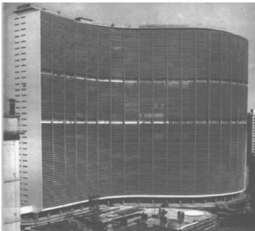
Figura 21. Edifício Copan, São Paulo, Oscar Niemeyer (1950).
