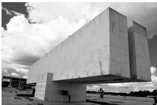
Figura 86. Museu da Fundação de Brasília – apoio excêntrico.
