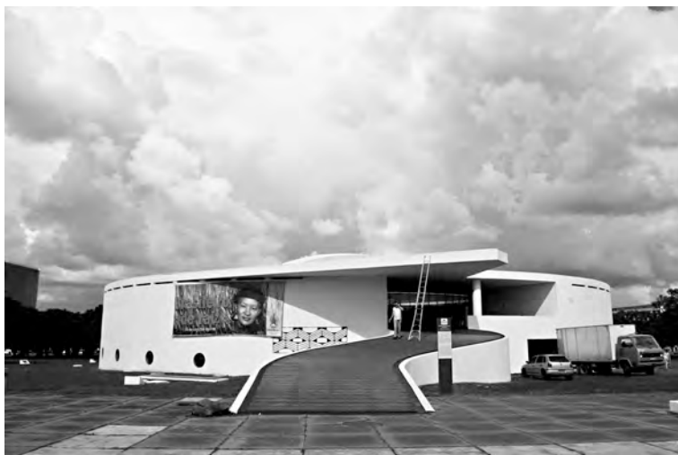
Figura 137. Museu do Índio – fachada com aberturas no térreo.
