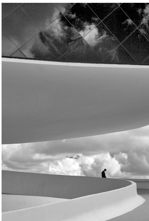
Figura 212. Museu Oscar Niemeyer – escala monumental do balanço de 30 metros do Edifício “Olho”.
