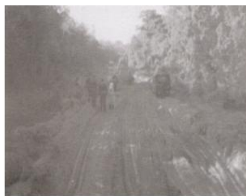
Abertura de estrada p/ acesso
