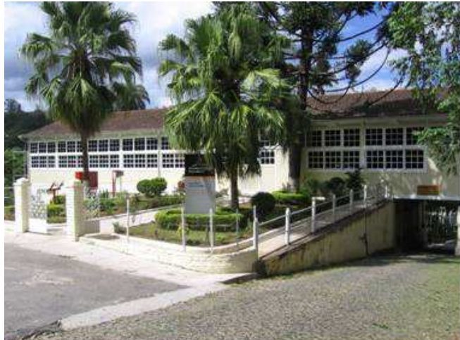
FIGURA 4.11 – Fachada lateral, com o acesso principal ao edifício.
