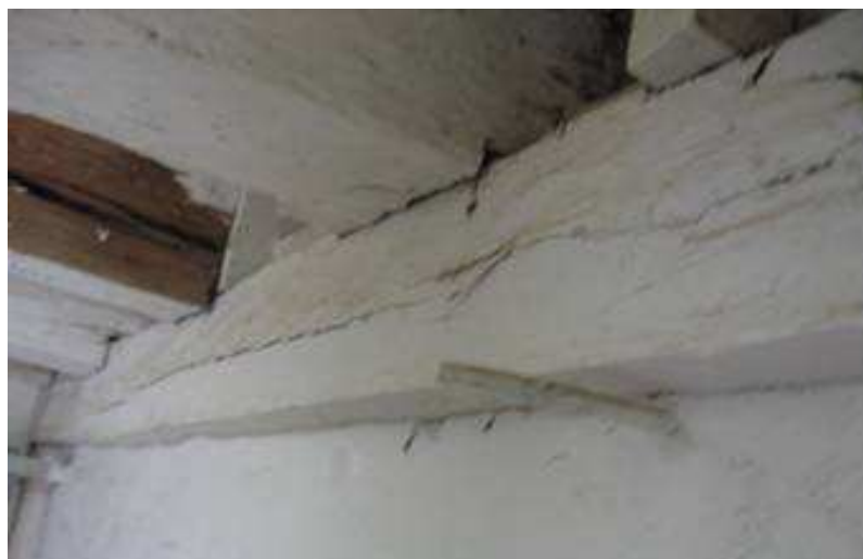
FIGURA 4.14 – Viga principal e vigas secundárias de suporte do segundo piso.
