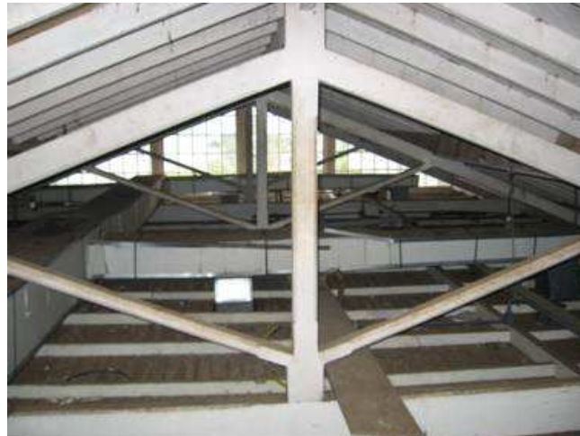
FIGURA 4.12 – Detalhe das tesouras da estrutura da cobertura.
