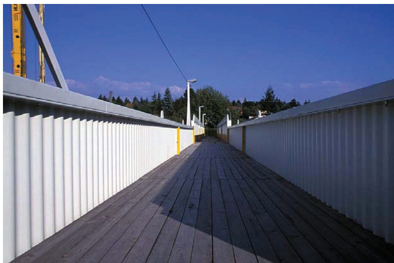
FIGURA 1.10 - Passarela em alma corrugada [PLAIS (2005)]
