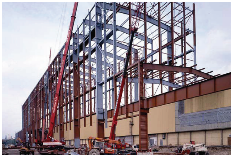
FIGURA 1.9 - Galpão industrial em alma corrugada [PLAIS (2005)]
