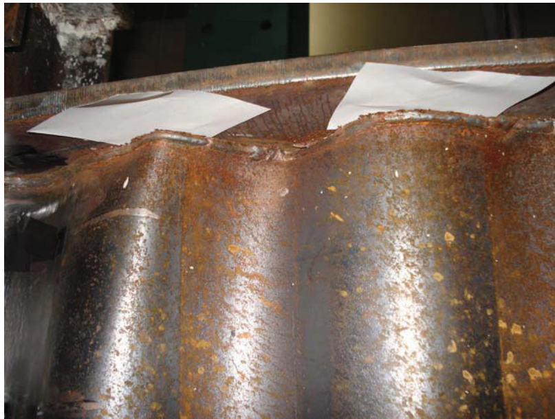
FIGURA 3.17 – Ruptura da solda entre a mesa comprimida e a alma (Protótipo 1)
