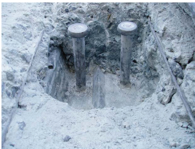
FIGURA 3.26 – Conectores de cisalhamento do Protótipo 3 após o ensaio
