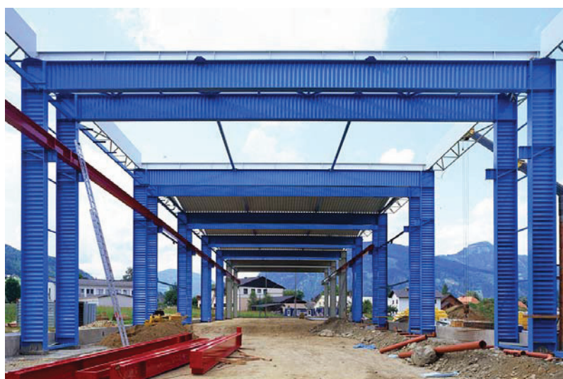
FIGURA 1.8 - Galpão comercial em alma corrugada [PLAIS (2005)]
