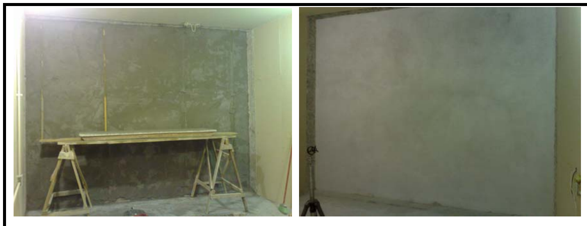
Figura 25 – Parede revestida na face externa (A3)
