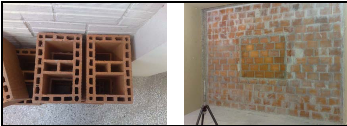
Figura 23 – blocos de alvenaria estrutural nas dimensões 190x190x290 mm e parede executada
