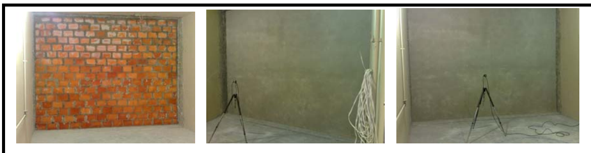
Figura 45 – Evolução da parede de acordo com os ensaios: parede em osso, revestimento na face externa e revestimento na face interna.
