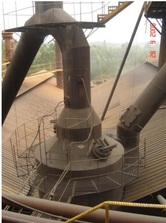
Figura 3. Detalhe de um coletor de pó gerado na saída de gases.
