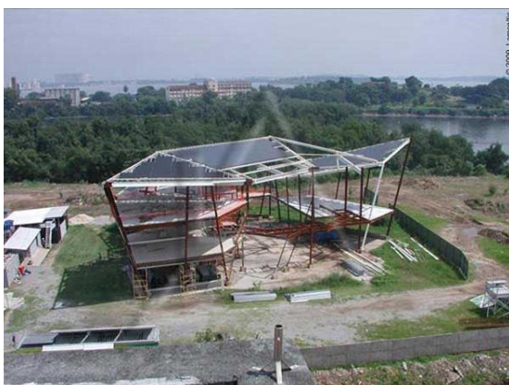
Figura 30 – Obra do LabCog em março de 2008.
