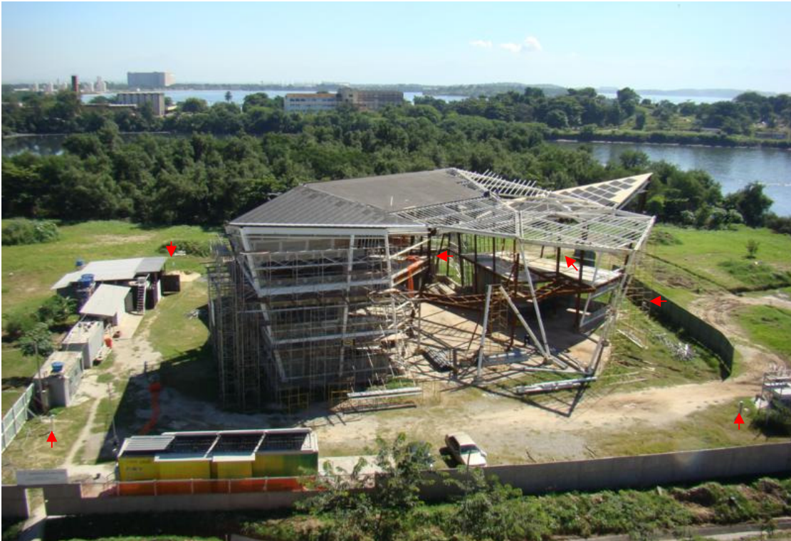
Figura 25 – Locais dos pontos de acesso na obra
