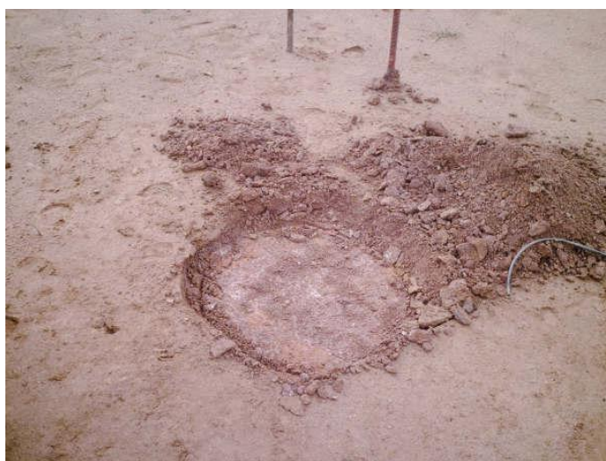
Figura 3.3: Escavação para a colocação da PFLI.
