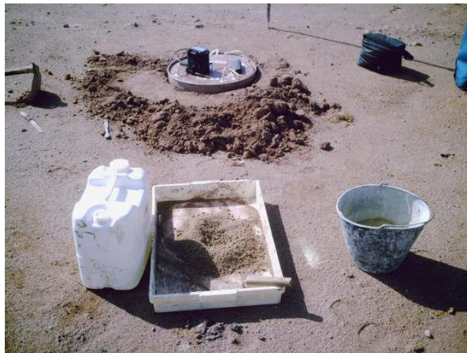
Figura 3.5: Preparação da mistura bentonita e solo.
