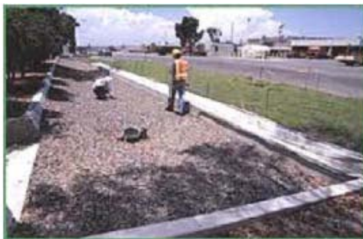
Figura 2.2 - Trincheira de infiltração (AMEC, 2001).
