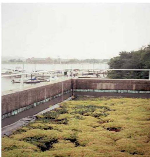
Figura 2.5- Detenção em telhados (WOODWORTH, 2002).
