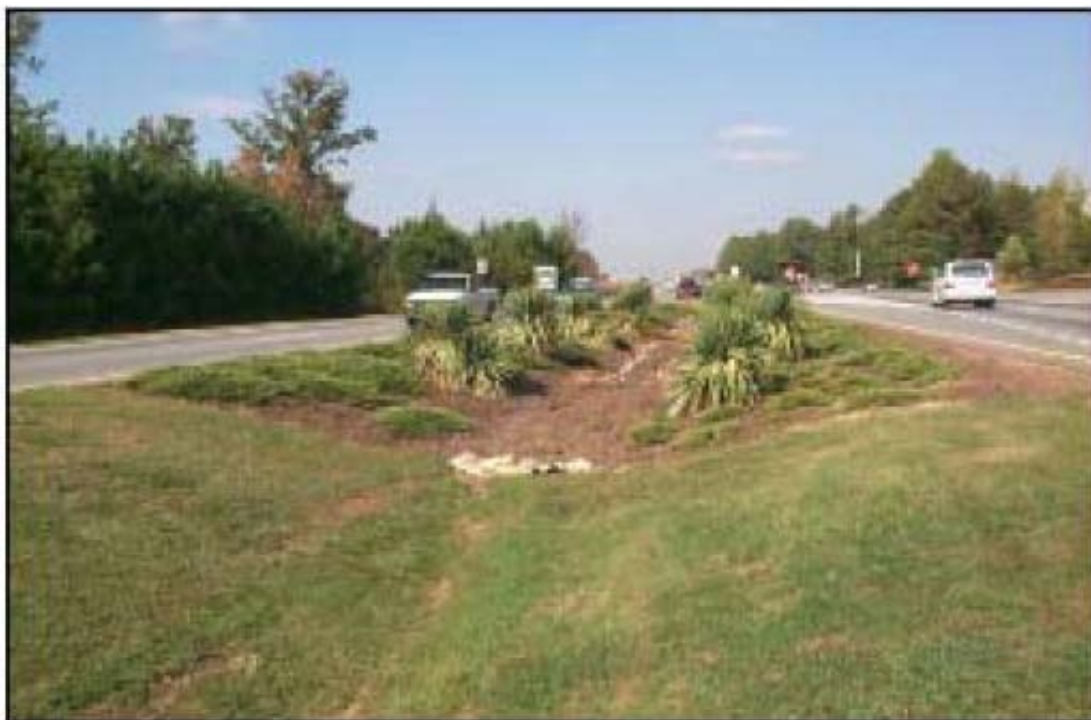
Figura 2.1 - Valo de infiltração (AMEC, 2001).
