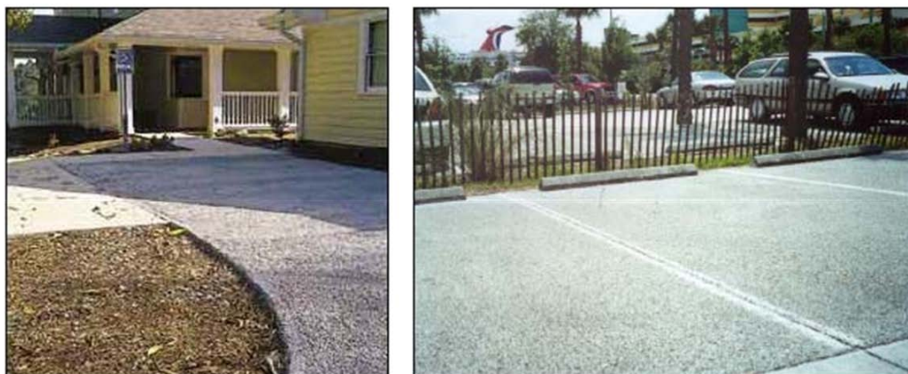
Figura 2.4 - Pavimento permeável (AMEC, 2001).
