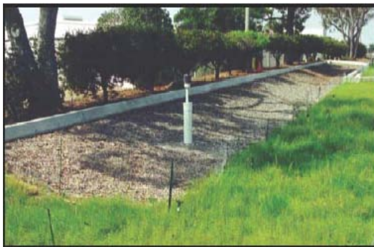
Figura 2.3 - Trincheira de infiltração (CASQA, 2003).
