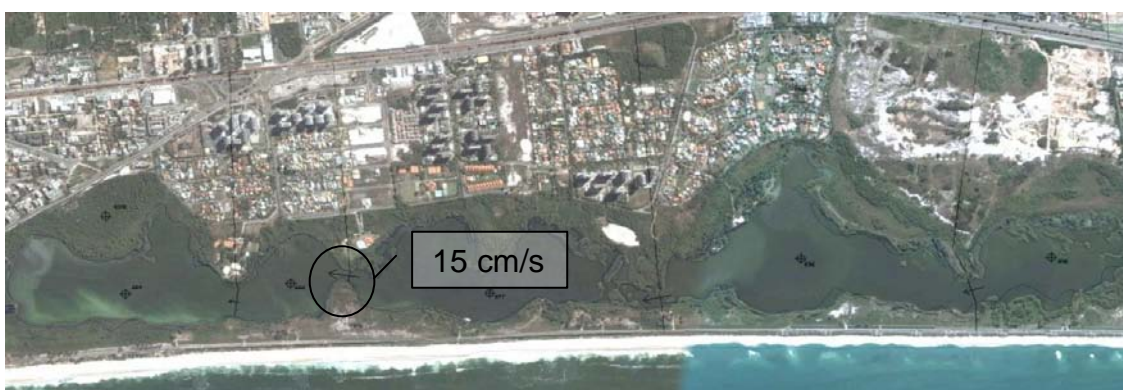
Figura 6.21 - Velocidades máximas de escoamento entre as células na lagoa de Marapendi atualmente com uma chuva de 20 anos de tempo de retorno.
