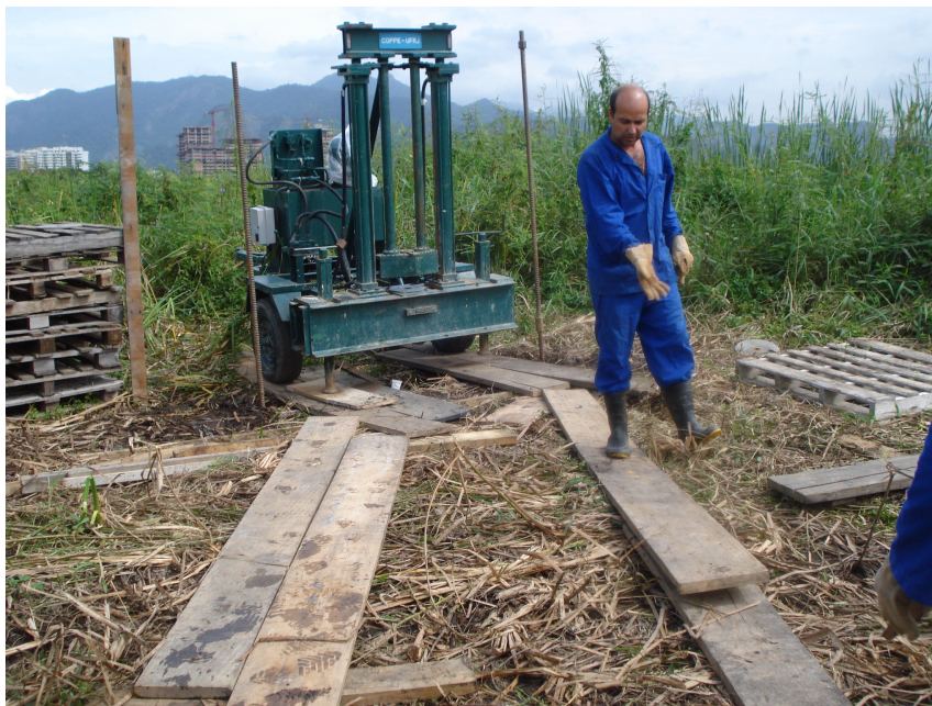
Figura 4. 5: Pranchões utilizados no deslocamento da máquina de cravação
