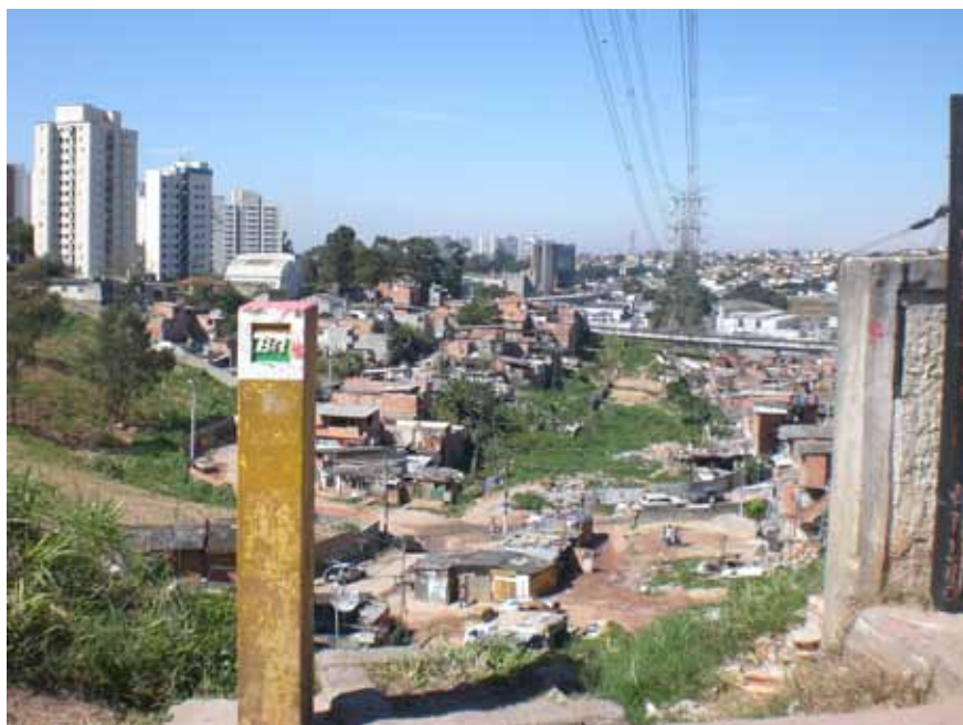
FAVELA PRÓXIMA A AV. GIOVANNI GRONCHI E METRÔ CARRÃO.
