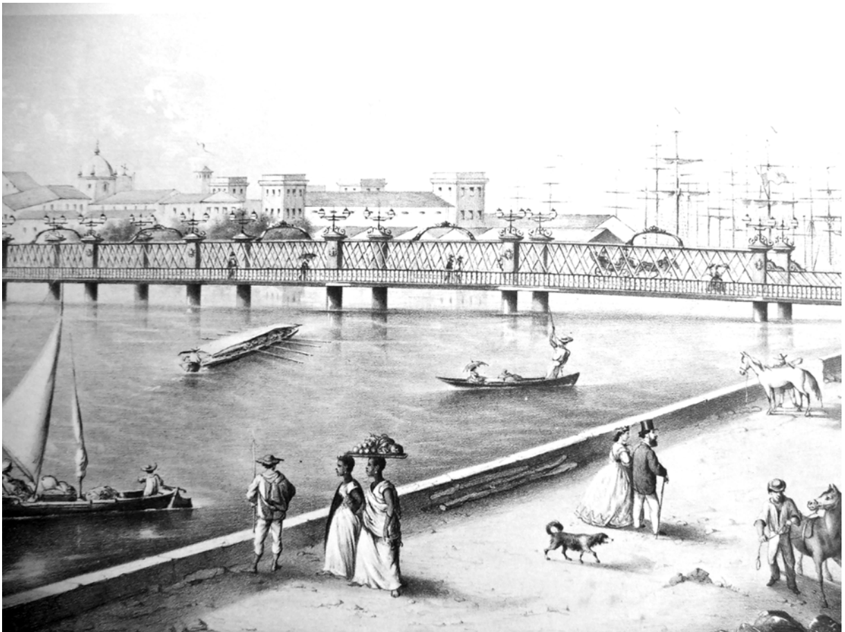
Ilustração 1 - Vista da ponte nova do Recife (Ponte Sete de setembro, inaugurada em 1865, no lugar da velha ponte de madeira construída no tempo de Maurício de Nassau). MENEZES. José Luiz Mota (org.). Atlas Histórico Cartográfico do Recife . Recife: Fundação Joaquim Nabuco/ Massangana, 1988.
