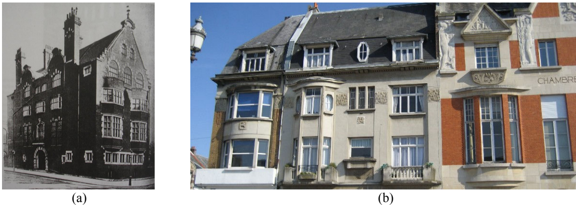
Figura 0-02 – Tipologia de “Janela em Sacada”: O Bow Window do século XVIII (a), a “Janela em Sacada” em diferentes formas (b).
