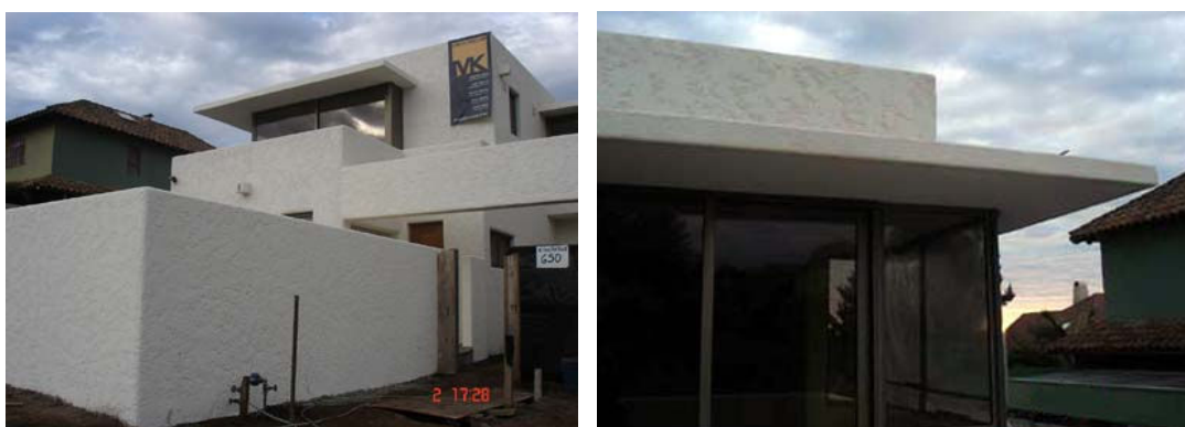
Figura 1-17 – O Beiral: uma proteção solar para uma “Janela em Sacada”.
