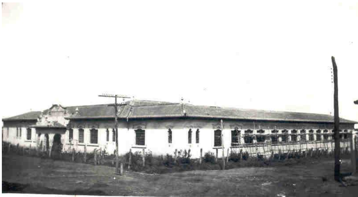
FIGURA 8 - Vista parcial da construção – lado direito (1951)
