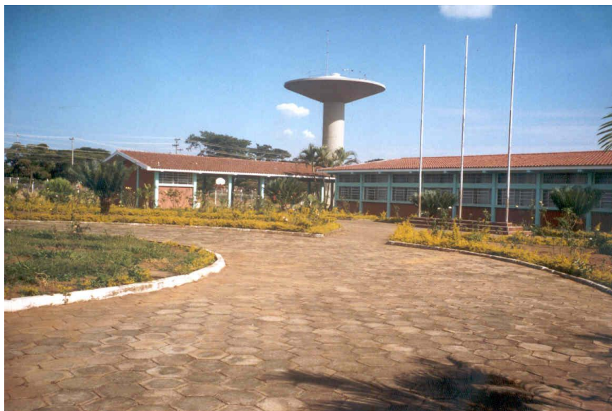
FIGURA 13 - Vista parcial da praça interna localizada na parte frontal do prédio da Unidade II da Escola Pestalozzi onde também funciona a Unidade II do lar-escola.
