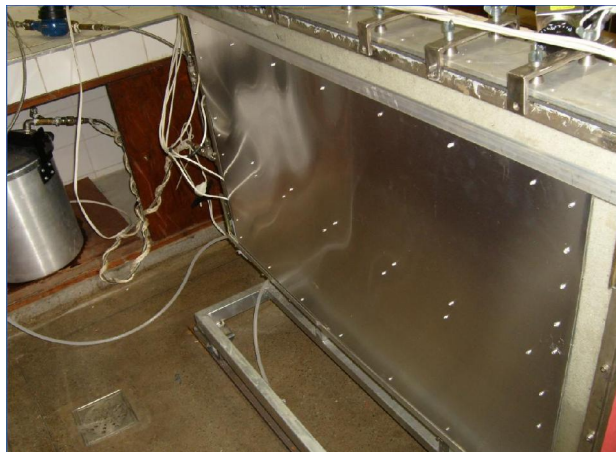
Figura 4.6 Placa aquecedora instalada sobre a face de vidro da primeira caixa de inox.
