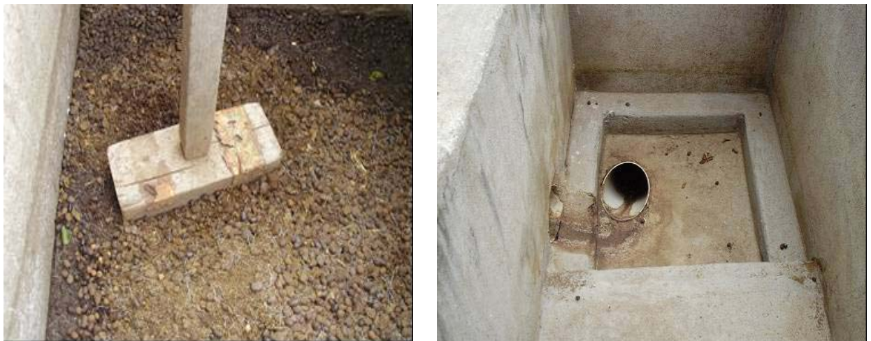
Figuras 17 e 18 - Pilão para amassar o estrume. A caixa recebe o estrume amassado dissolvido em água. Fonte: Elaboração própria, 2009
