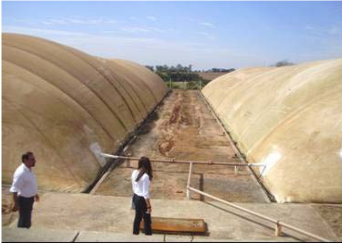
Fig. 09-Biodigestor industrial, modelo canadense, para produção de biogás, biofertilizante e venda de créditos de carbono. Fazenda Santa Rosa, Embu (S.P.), 2009.
