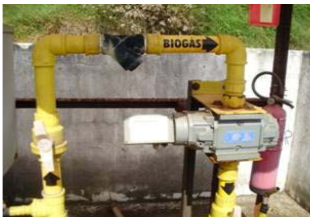
Figura 12 e 13 - Medição do biogás para venda de créditos de carbono na Fazenda Santa Rosa, Embu, (S.P.), 2009.
