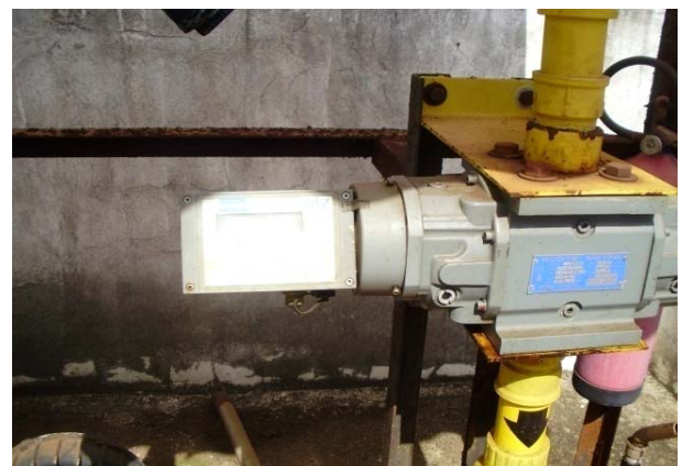
Figura 12 e 13 - Medição do biogás para venda de créditos de carbono na Fazenda Santa Rosa, Embu, (S.P.), 2009.
