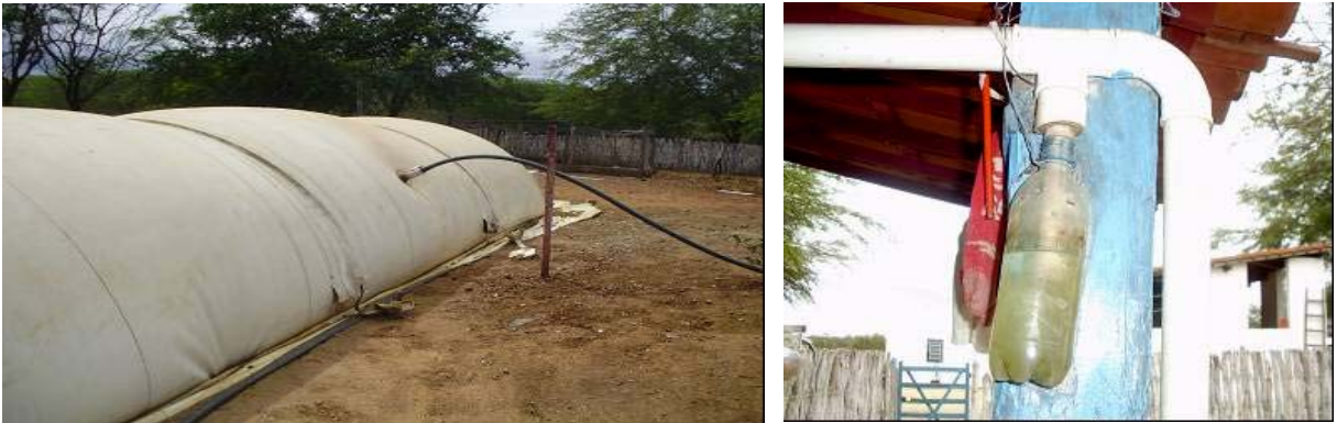
Figuras 25 e 26 - Saída do biogás acoplado a um sistema de controle de pressão no biodigestor.
