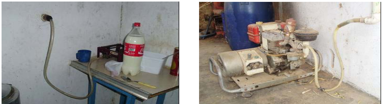
Figuras 27 e 28 - Uso do biogás para cocção e geração de eletricidade.
