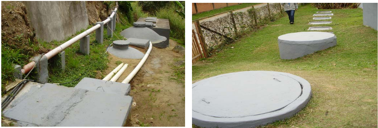
Figura 42 e 43 - Biodigestores e reservatório de biogás. Sistema de tratamento de dejetos urbanos da empresa Águas do Imperador, Petrópolis, Rio de Janeiro, 2009.
