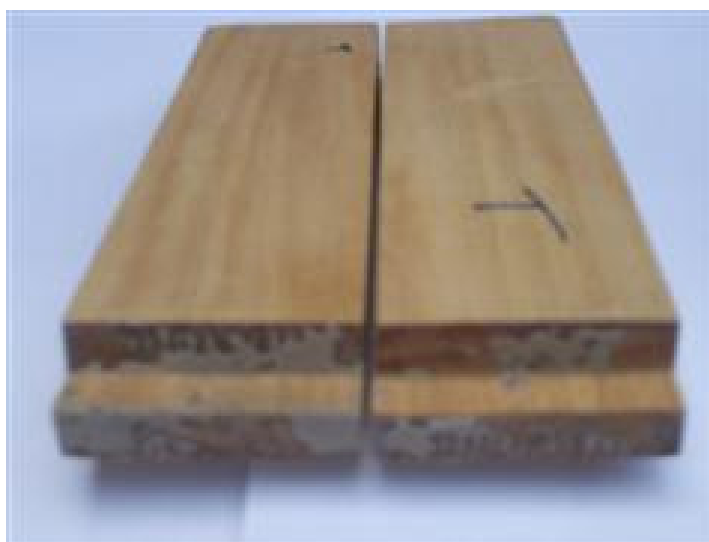
Figura 53: Representação da ruptura típica das juntas coladas encaixadas confeccionadas com o Tauari.
