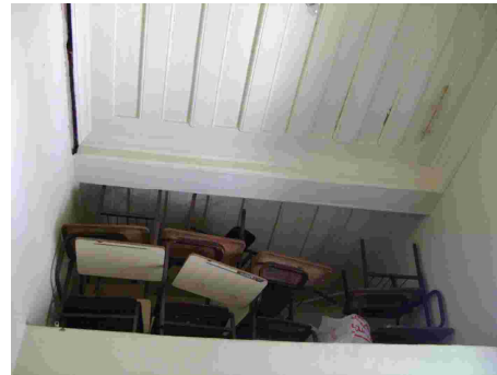
Fig. 227 – Detalhe do forro em tabuado de madeira, padrão saia e camisa. Estação de Alberto Torres. Fonte: CGLucas, 2010.
