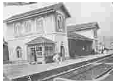
Fig. 07 – Estação original de Engenho de Dentro, Rio de Janeiro. 1910.
