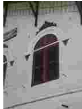
Figs. 328 e 329 – Detalhe das mãos-francesas em madeira e dos ornatos em argamassa, na fachada da estação principal. Fonte: CGLucas (2010)
