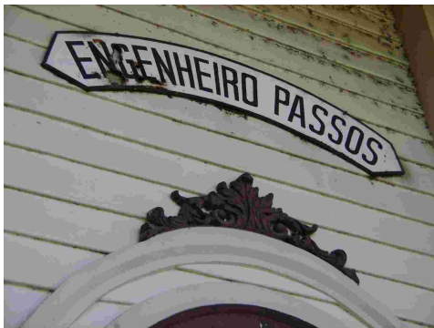
Fig. 336 – Detalhe da placa com o nome da estação e do florão decorativo, ambos em argamassa. Fonte: CGLucas (2010)
