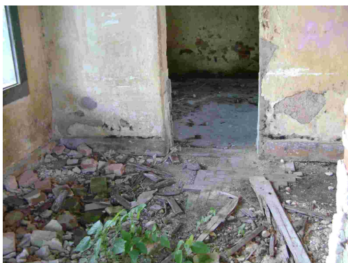
Fig. 263 – Detalhe do piso em tacos de madeira da Estação de Joaquim Leite.
