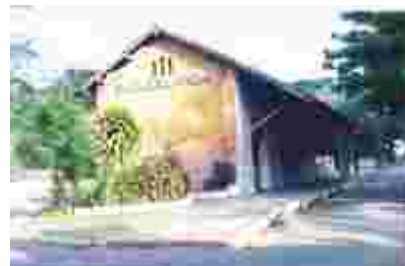
Fig. 69 – Estação original de Euclidelândia, Cantagalo. 2003.
