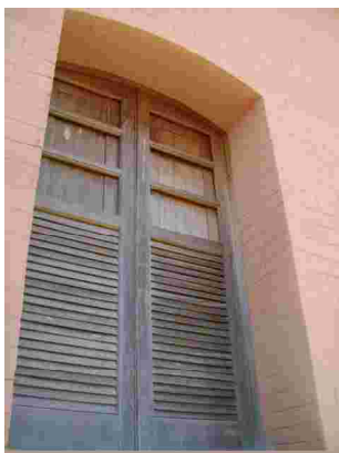
Fig. 183 – Detalhe da janela da Estação de Guia de Pacobaíba. Fonte: CGLucas (2010)
