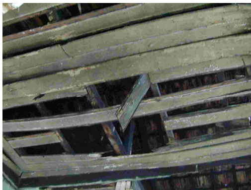
Fig. 267 – Detalhe do forro em tabuado de madeira da Estação de Joaquim Leite. Fonte: CGLucas, 2010.
