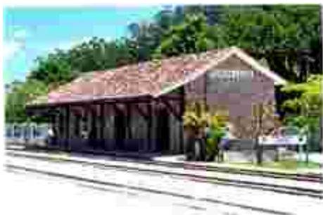
Fig. 249 – Cobertura da Estação de Rocha Leão. Fonte: CGLucas, 2010.
