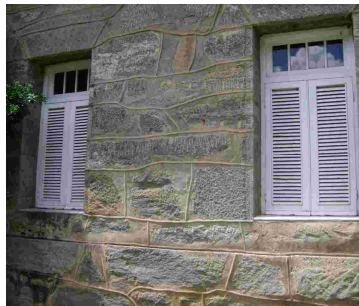
Fig. 229 – Janelas da Estação de Alberto Torres. Fonte: CGLucas, 2010.
