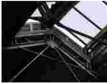
Fig. 368 – Detalhe da estrutura metálica do lanternin. Fonte: CGLucas (2009)
