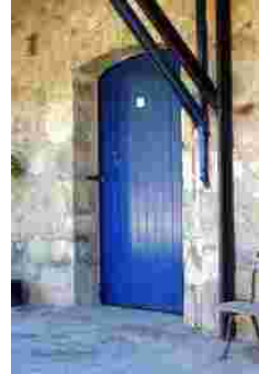
Fig. 240 – Detalhe da porta em tabuado e vão em arco de pedra da Estação de Rocha Leão. Fonte: Centro Ferroviário de Cultura Guilherme Nogueira, 2010
