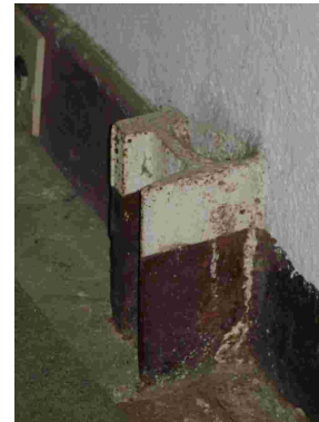
Fig. 221 – Detalhe da viga "I" na estação de Três Rios. Fonte: CGLucas, 2010.
