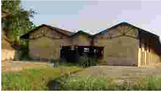
Fig. 373 – Vista da fachada posterior da estação. Detalhe para a tesura metálica de sustentação da cobertura da plataforma. Fonte: CGLucas (2009)
