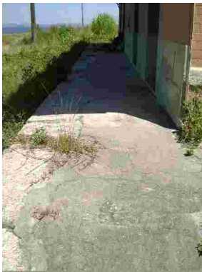
Fig. 180 – Plataforma da Estação de Guia de Pacobaíba. Fonte: CGLucas (2010)
