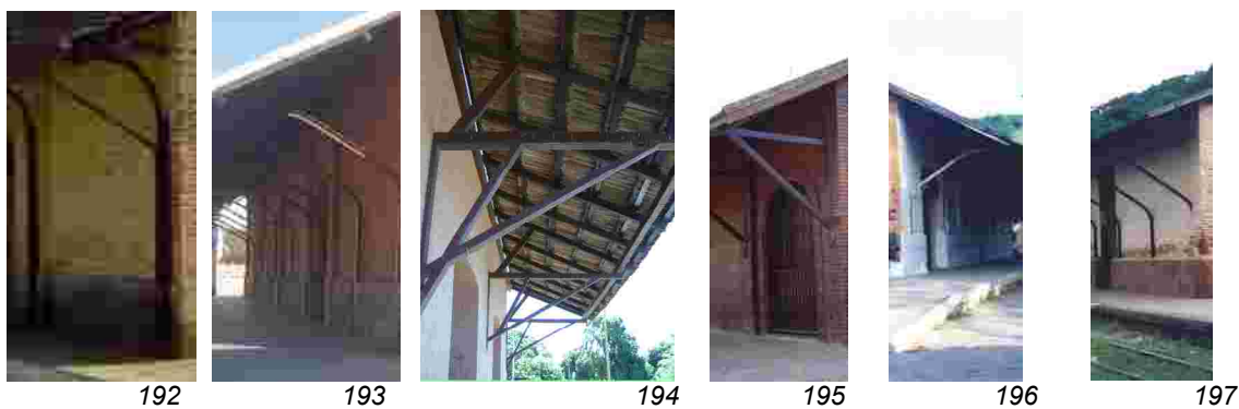
Figs. 192 a 197 - Variação dos desenhos e materias das mãos-francesas. Por ordem: estações de Santo Eduardo, Conceição de Macabú, Guia de Pacibaíba, Porciúncula, Euclidelândia e Pureza.
