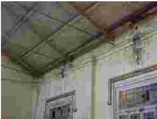
Fig. 354 e 355 – Detalhe do forro em tabuado de madeira no telhado em duas águas da sala de espera e no pavimento superior. Fonte: CGLucas (2009)
