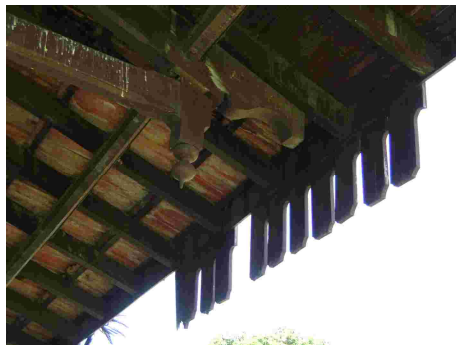
Figs. 326 e 327 – Detalhe do lambrequim na ponta do telhado do armazém. Fonte: CGLucas (2010)
