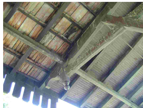
Fig. 321 – Detalhe do beiral, parte em estrutura visível, parte com forro de madeira, do armazém. Fonte: CGLucas (2010)
