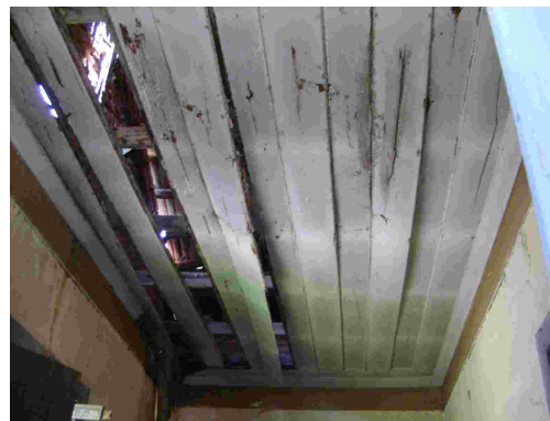
Fig. 268 – Detalhe do forro em tabuado de madeira da Estação de Antonio Rocha. Fonte: CGLucas, 2010.
