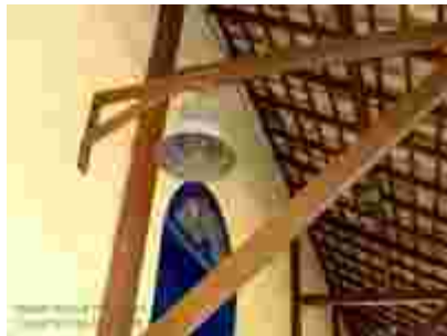
Fig. 152 – Detalhe da mão-francesa simples da Estação de Casimiro de Abreu, Casimiro de Abreu. 2005. Fonte: www.estacoesferroviarias.com.br , acessado em maio de 2009.
