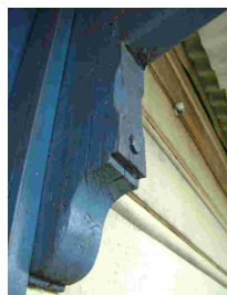
Fig. 302 e 303 – Estação de Pulverização. Detalhe das mãos-francesas em madeira maciça. 2010. Fonte: CGLucas
