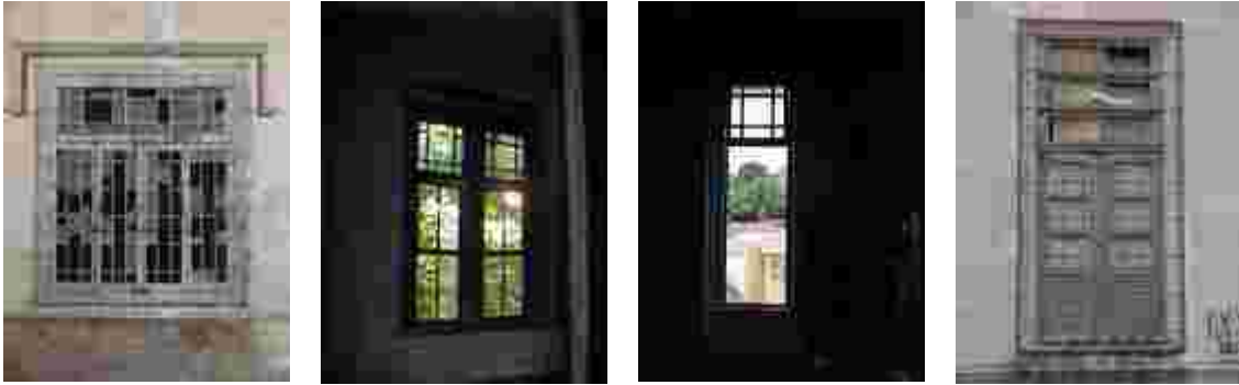
Fig. 356 e 359 – Vista de algumas esquadrias da estação principal. Fonte: CGLucas (2009)
