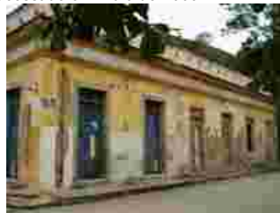
Fig. 156 – Detalhe da fachada principal do armazém da Estação de Arcádia, Miguel Pereira. 2004. Fonte: www.estacoesferroviarias.com.br , acessado em maio de 2009.
