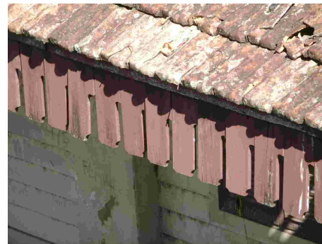
Figs. 326 e 327 – Detalhe do lambrequim na ponta do telhado do armazém. Fonte: CGLucas (2010)
