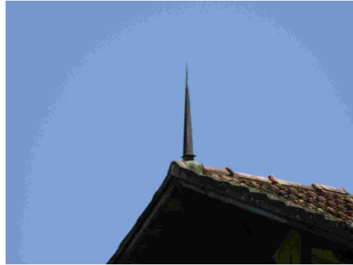
Fig. 331 – Detalhe do acabamento em ferro existente nas cumeeiras da estação. Fonte: CGLucas (2010)
