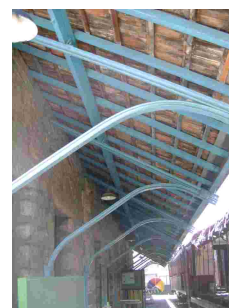
Fig. 253 – Detalhe das mãos francesas em ferro da Estação de Três Rios - EFL. Fonte: CGLucas, 2010.
