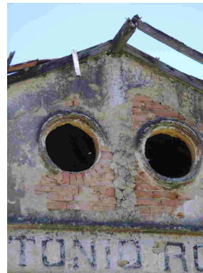
Fig. 274 – Detalhe dos óculos da Estação de Antonio Rocha. Fonte: CGLucas, 2010.
