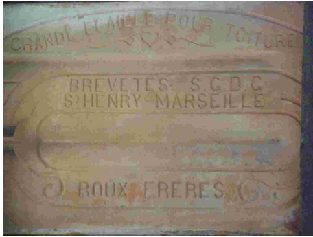
Figs. 324 e 325 – Detalhe das inscrições em telhas cerâmicas instaladas na cobertura do armazém. Fonte: CGLucas (2010)
