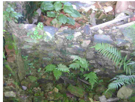
Fig. 259 – Detalhe do assentamento das pedras brutas de parte do alicerce encontrado na Estação de Joaquim Leite. Fonte: CGLucas, 2010.
