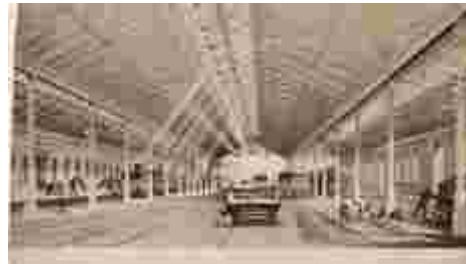
Fig. 100 – Interior da Estação de Derby, Inglaterra. Sem data. Fonte: www.sspiprints.com , acessado em maio de 2009.
