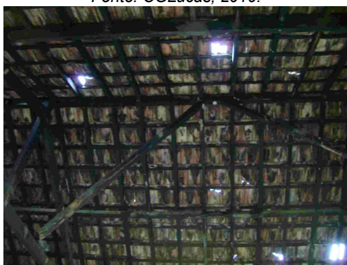
Fig. 277 – Detalhe da estrutura de madeira da Estação de Joaquim Leite. Fonte: CGLucas, 2010.
