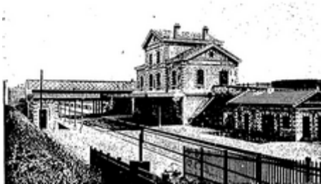
Fig. 88 – Estação em trincheira, Épina, Grande Ceinture, França. Sem data. Fonte: LEFÈVRE, 1889.
