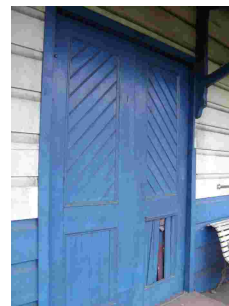
Figs. 296, 297 e 298 – Estação de Pulverização. Detalhe das esquadrias. Janelas de peitoril cheio, com duas folhas em venezianas, vidro e postigo; porta principal da estação com duas folhas, em venezianas, vidro e postigo; porta do armazém em duas folhas com tabuado de madeira na vertical e diagonal. 2010.
