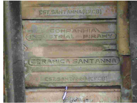
Figs. 324 e 325 – Detalhe das inscrições em telhas cerâmicas instaladas na cobertura do armazém. Fonte: CGLucas (2010)
