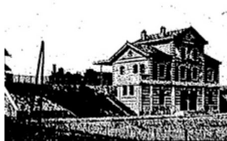
Fig. 87 – Estação em talude, Bourget, Grande Ceinture, França. Sem data. Fonte: LEFÈVRE, 1889.
