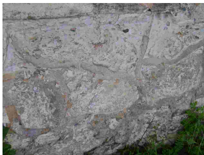
Fig. 260 – Detalhe do embasamento em pedra bruta com argamassa em barro da Estação de Joaquim Leite. Fonte: CGLucas, 2010.
