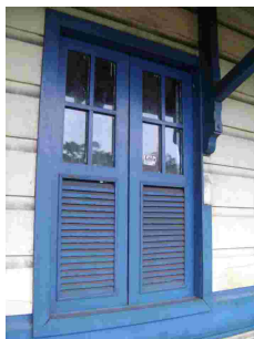
Figs. 296, 297 e 298 – Estação de Pulverização. Detalhe das esquadrias. Janelas de peitoril cheio, com duas folhas em venezianas, vidro e postigo; porta principal da estação com duas folhas, em venezianas, vidro e postigo; porta do armazém em duas folhas com tabuado de madeira na vertical e diagonal. 2010.
