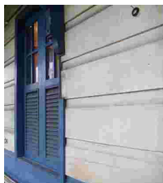
Fig. 300 e 301 – Detalhe do sistema de encaixe das peças de madeira das paredes externas. 2010. Fonte: CGLucas
