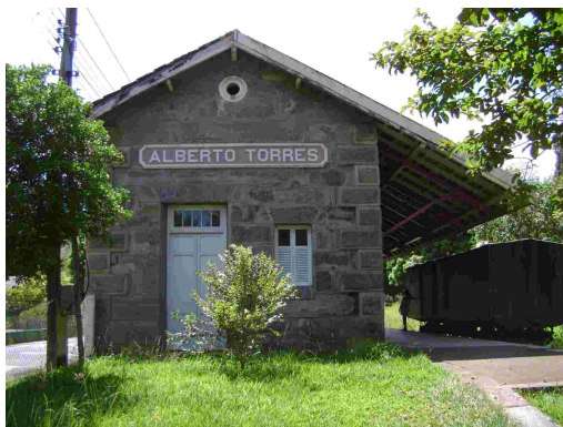
Fig. 217 – Estação de Alberto Torres. Fonte: CGLucas, 2010.
