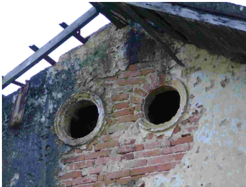
Fig. 273 – Detalhe dos óculos da Estação de Joaquim Leite. Fonte: CGLucas, 2010.
