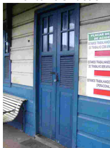
Figs. 296, 297 e 298 – Estação de Pulverização. Detalhe das esquadrias. Janelas de peitoril cheio, com duas folhas em venezianas, vidro e postigo; porta principal da estação com duas folhas, em venezianas, vidro e postigo; porta do armazém em duas folhas com tabuado de madeira na vertical e diagonal. 2010.
