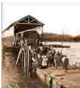
Figs. 198 e 199 – O primeiro píer executado, com estrutura de plataforma e cobertura em madeira (detalhe da tesoura da cobertura). Os passageiros desembarcavam do trem a, andando, se dirigiam até a plataforma de embarque do barco a vapor, ou vice-versa. Sem data.
