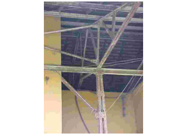
Fig. 372 – Detalhe da tesoura metálica de sustentação da cobertura da plataforma. Fonte: CGLucas (2009)
