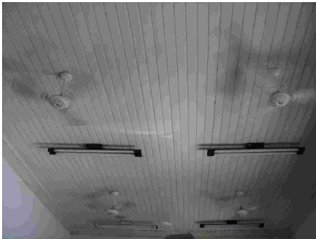
Fig. 226 – Detalhe do forro em tabuado de madeira, padrão liso, com mata-junta. Estação de Três Rios - EFL. Fonte: CGLucas, 2010.
