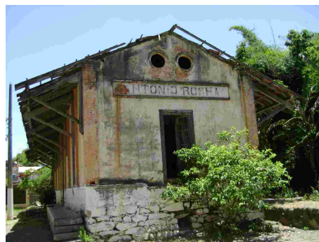
Fig. 276 – Detalhe da cobertura da Estação de Antonio Rocha. Fonte: CGLucas, 2010.
