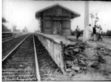
Fig. 282 – Estação de Paciência, Rio de Janeiro. Sem data.
