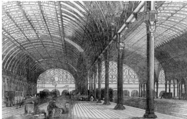
Fig. 122 – Cobertura das plataformas da segunda estação de Paddington, Inglaterra. 1854. Fonte: www.skyscrapercity.com , acessado em maio de 2009.
